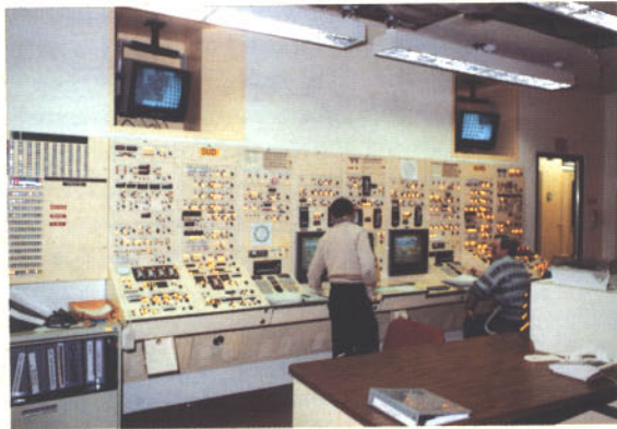
Le chargement et le retrait du combustible se fait à distance, au moyen de machines télécommandées à partir de la salle de commande. Des caméras situées face au réacteur permettent de suivre les opérations sur des écrans.
