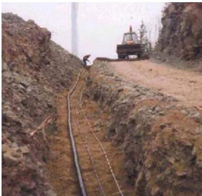
Figure 2.1-4 : Enfouissement de lignes électriques
