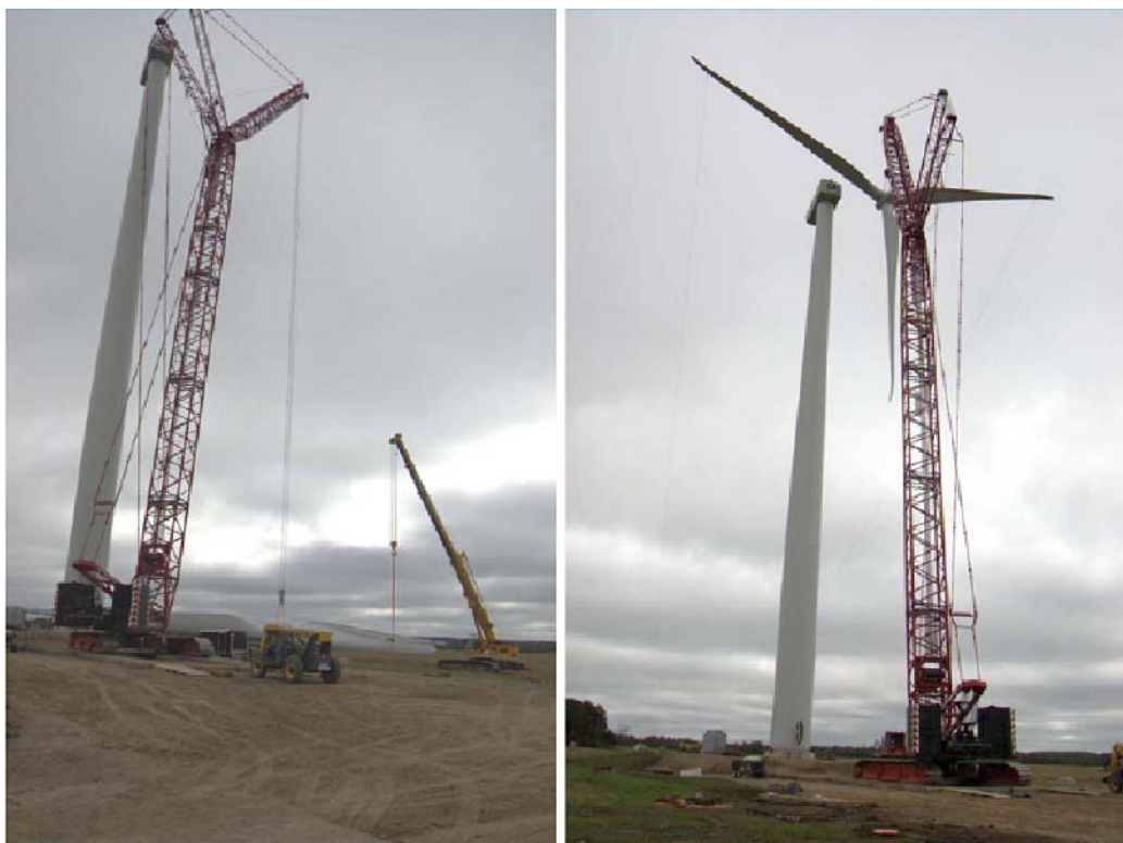
Figure 2.1-8 : Installation du rotor d'une éolienne
