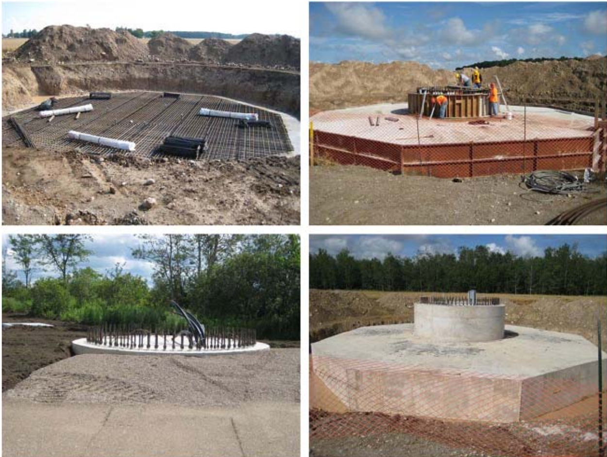
Figure 2.1-7 : Préparation de la fondation
