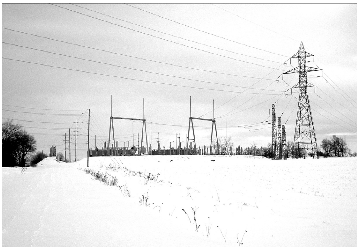
Le courant généré par les 133 éoliennes de Melancthon converge dans une sous-station électrique avant d'être envoyé sur une ligne à haute tension.
