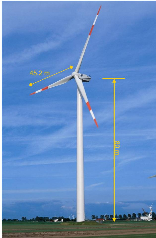
Figure 2.2-1 : Éolienne-type (exemple du modèle REpower MM92)
