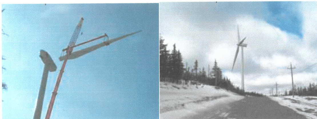
Figure 3.2 Levage des pales et éolienne complétée
