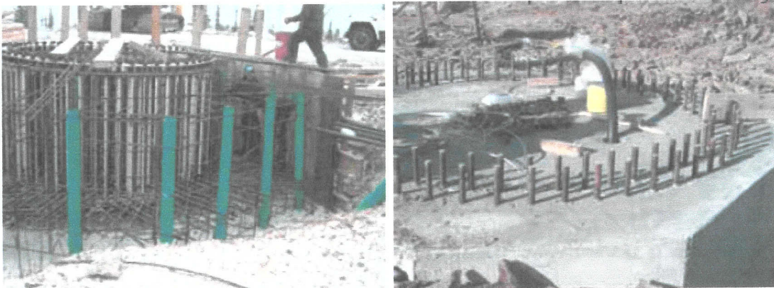
Figure 3.1 Fondation excavée avec armature et fondation complétée avec ancrages
