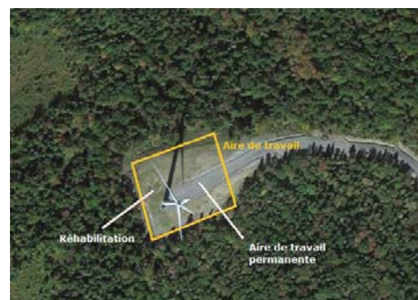
Réhabilitation d'une aire de travail
