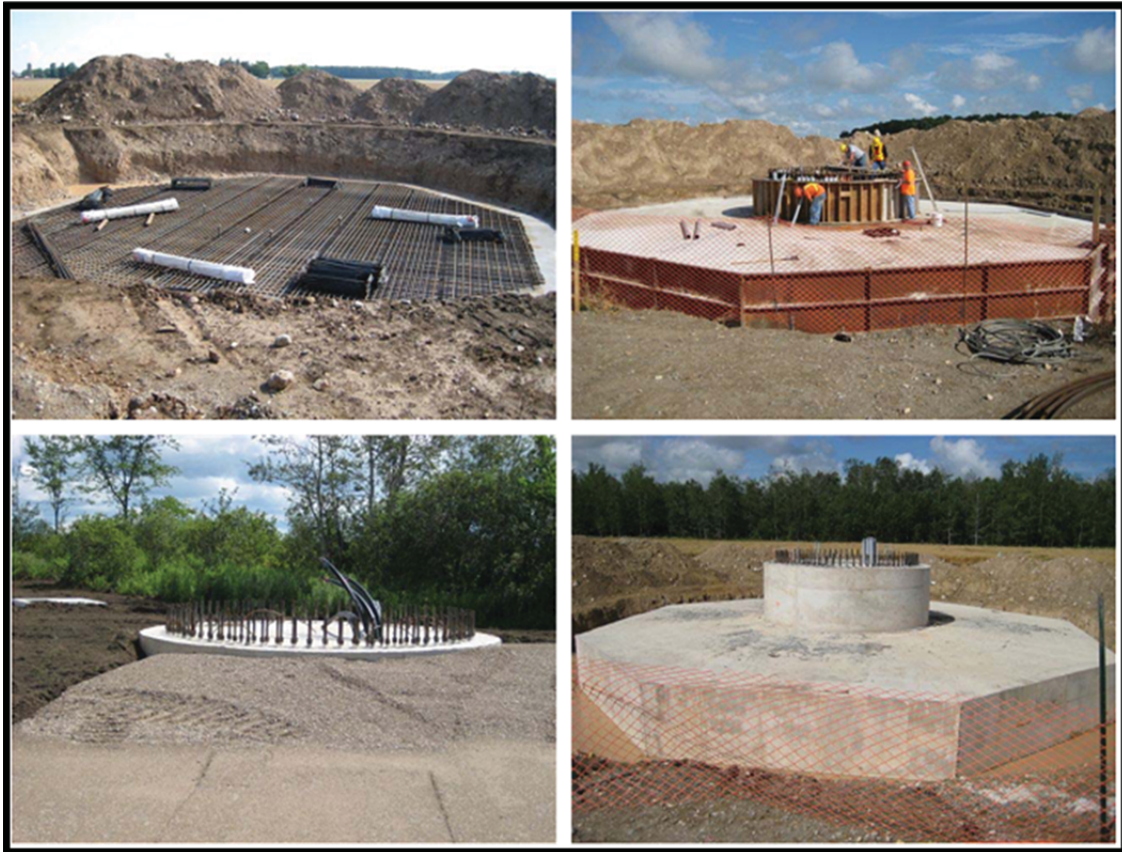
Figure 2-2 Préparation d'une fondation de masse
