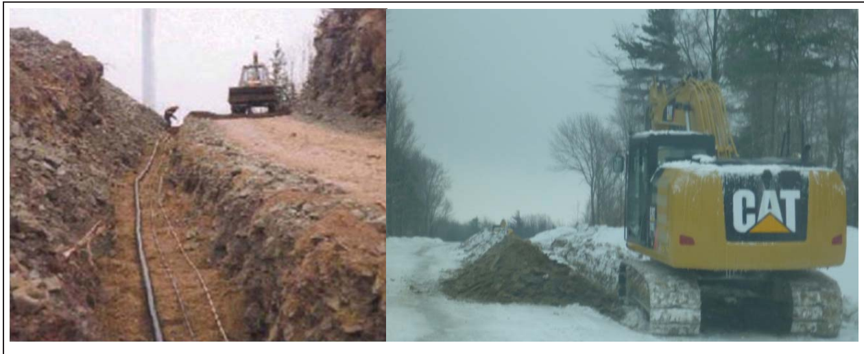
Figure 2-7 Enfouissement de lignes électriques
