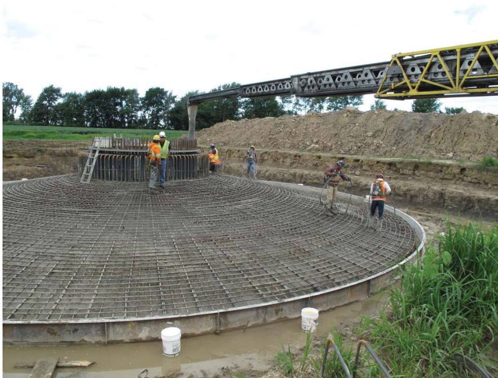
Figure 2-3 Préparation d'une fondation pour éolienne
