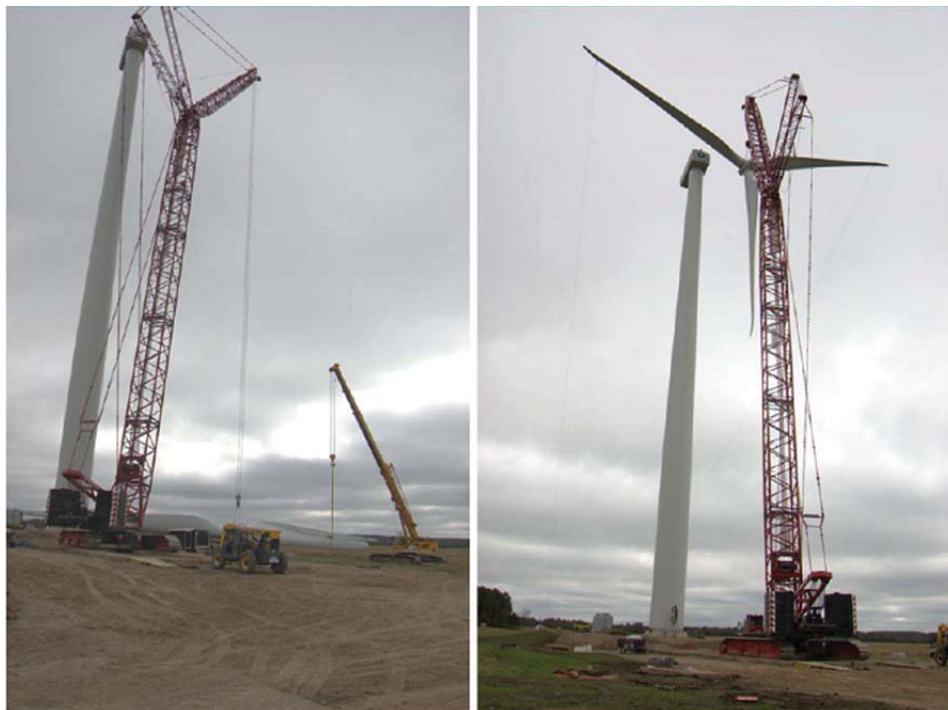
Figure 2-9 Installation du rotor d'une éolienne
