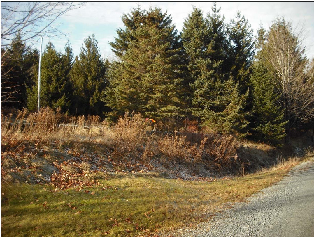
Photo 12 Zone 18, vue générale, vue vers l'ouest
