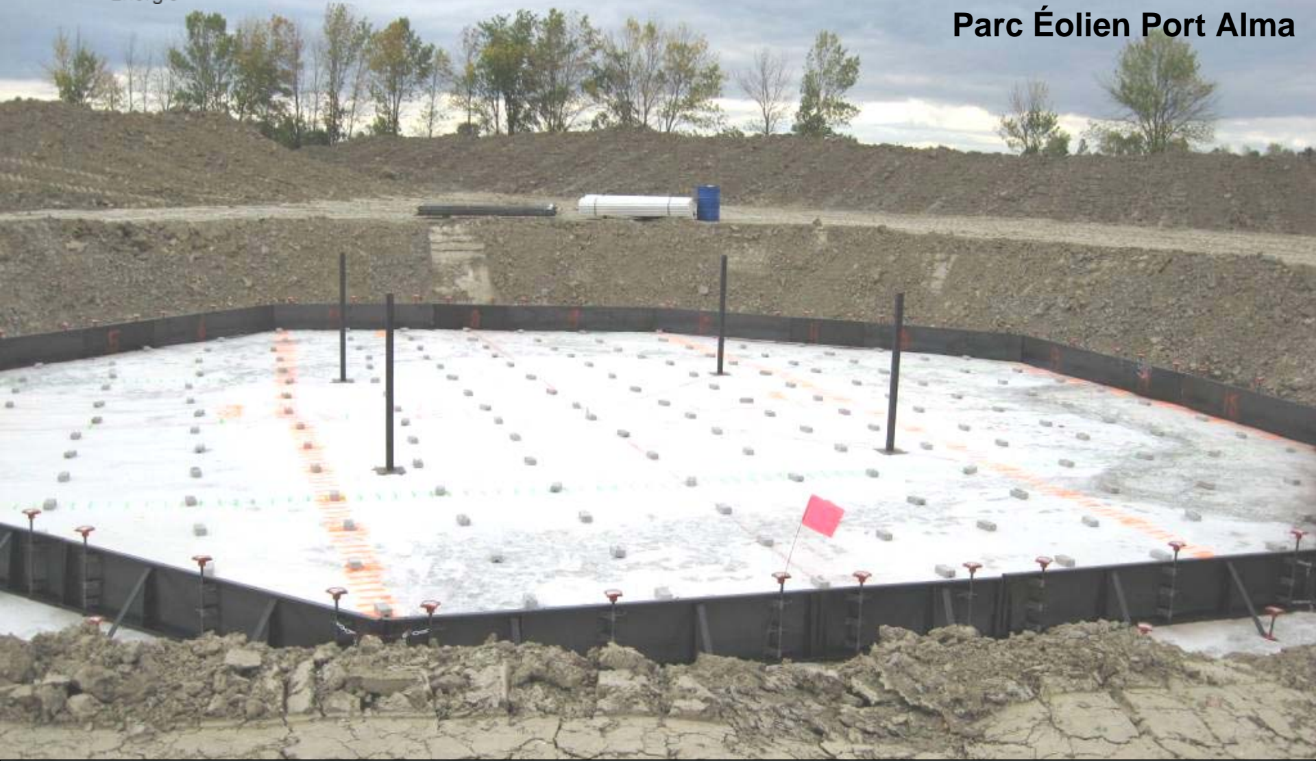
Fondation des éoliennes– Périmètre de béton
