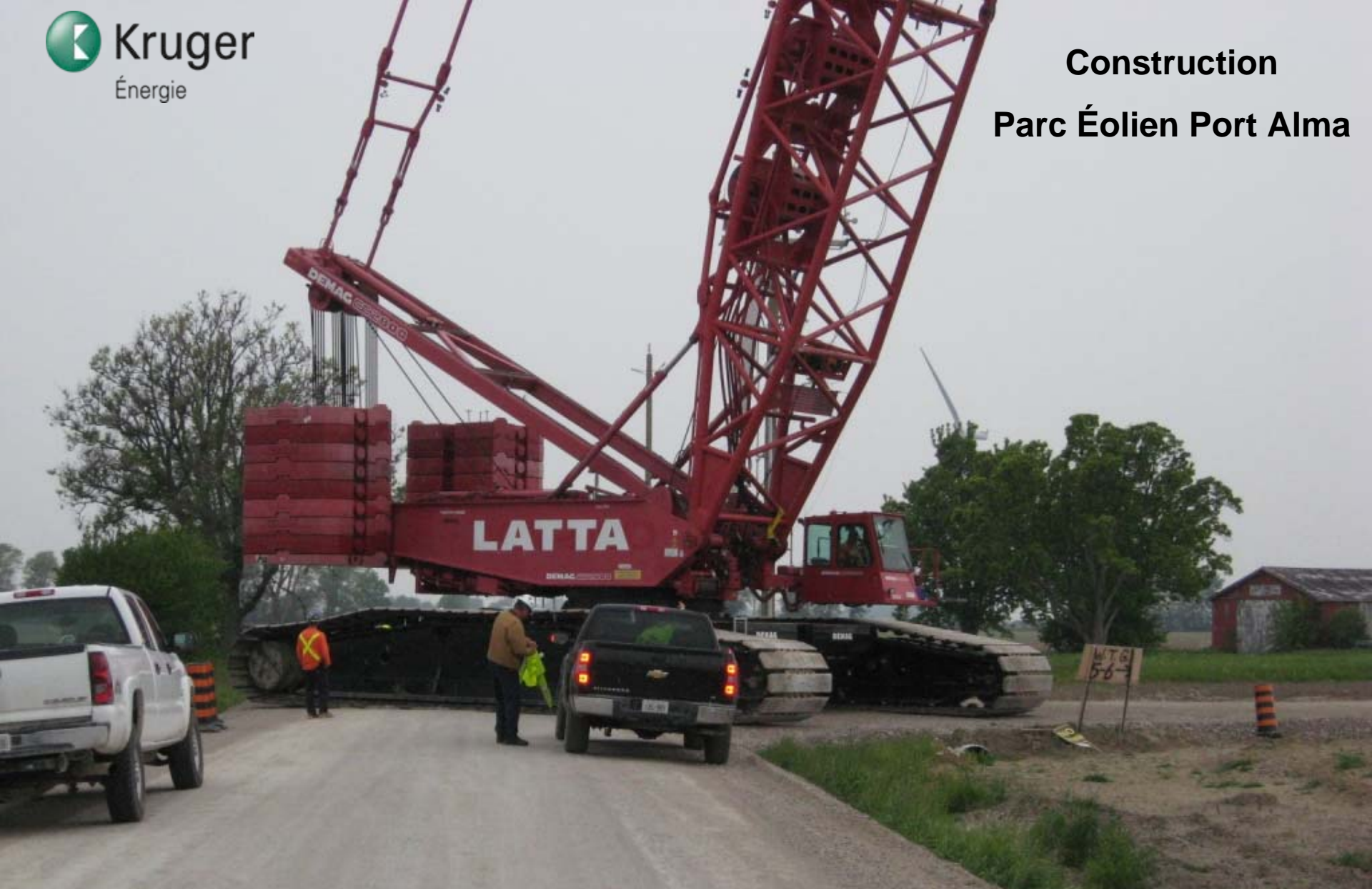
Grue en déplacement sur le site
