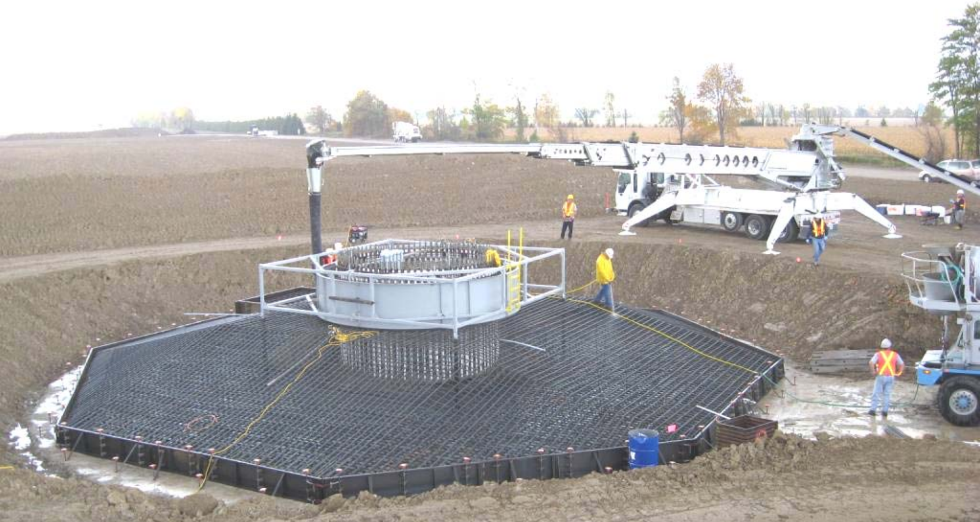
Fondation des éoliennes – Coulage du béton
