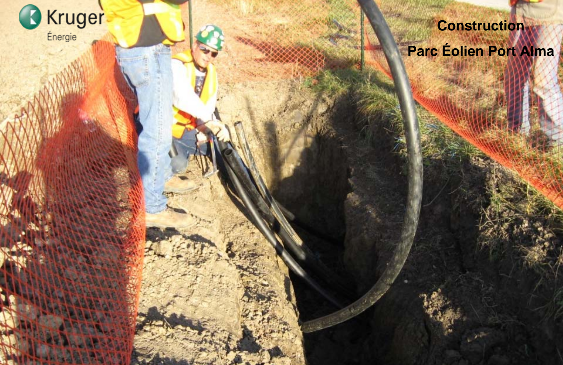
Conduite de plastique installée après le forage
