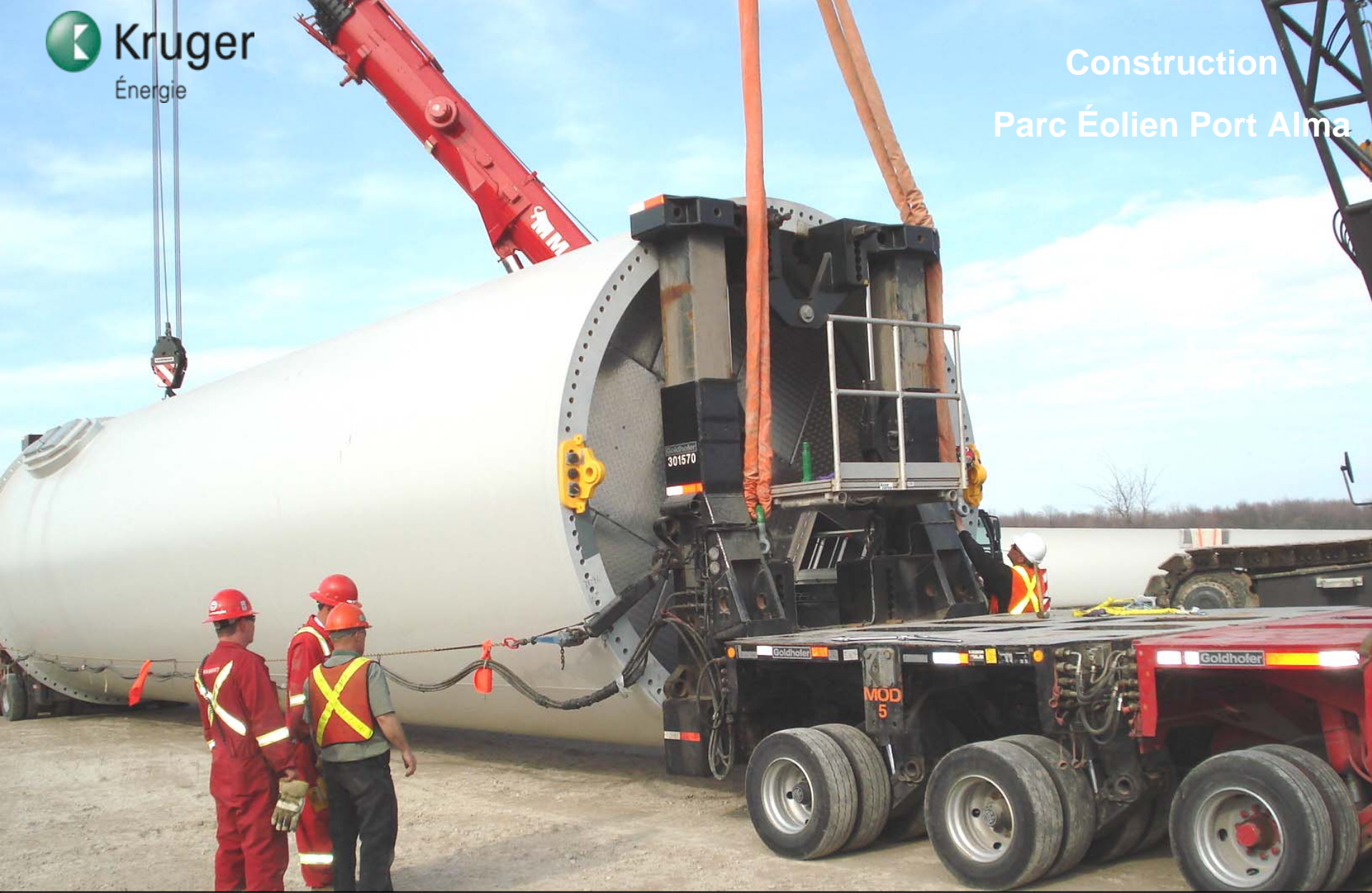
Déchargement d'une section de base d'éolienne
