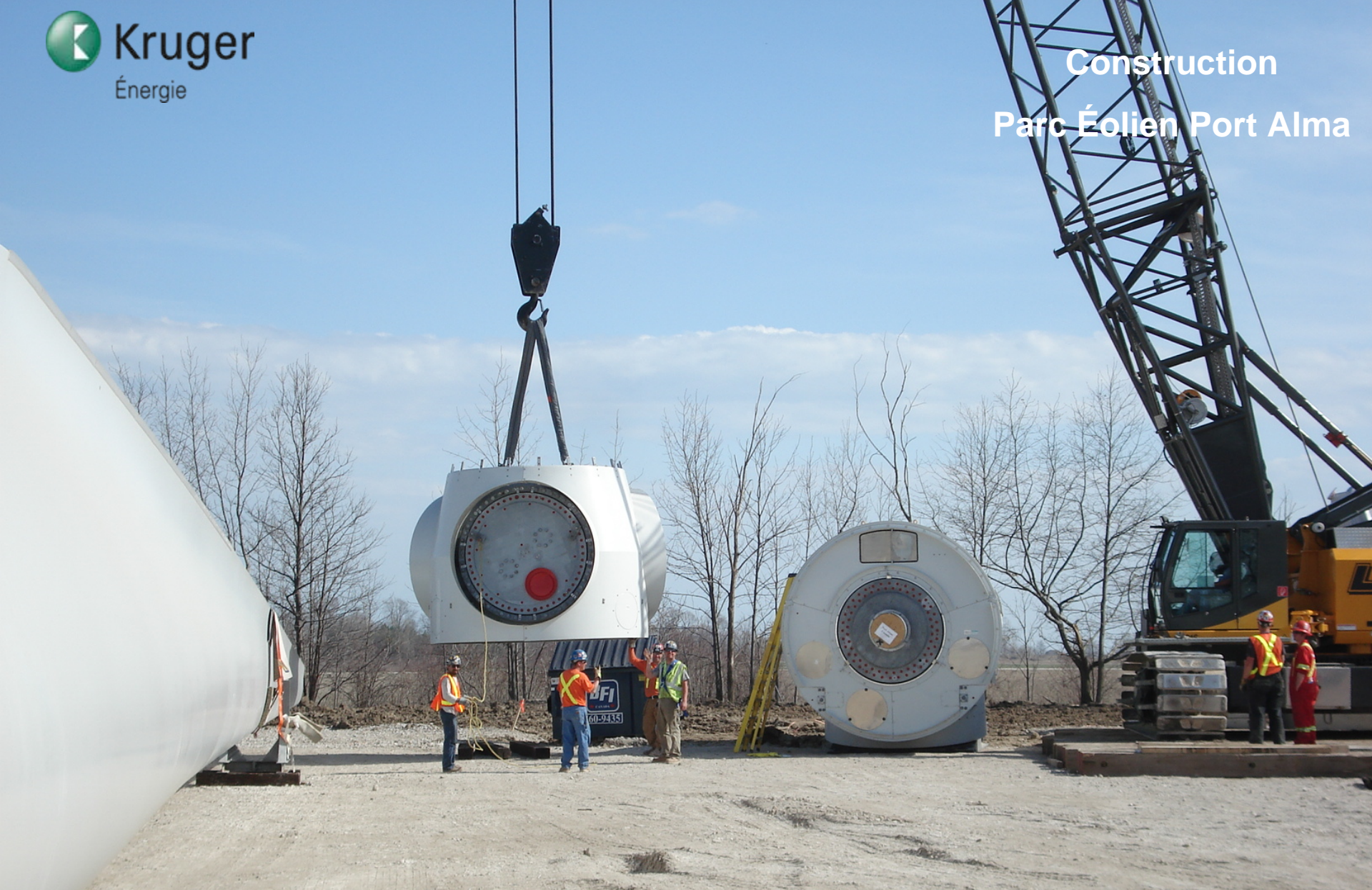
Déchargement d'un moyeu d'éolienne
