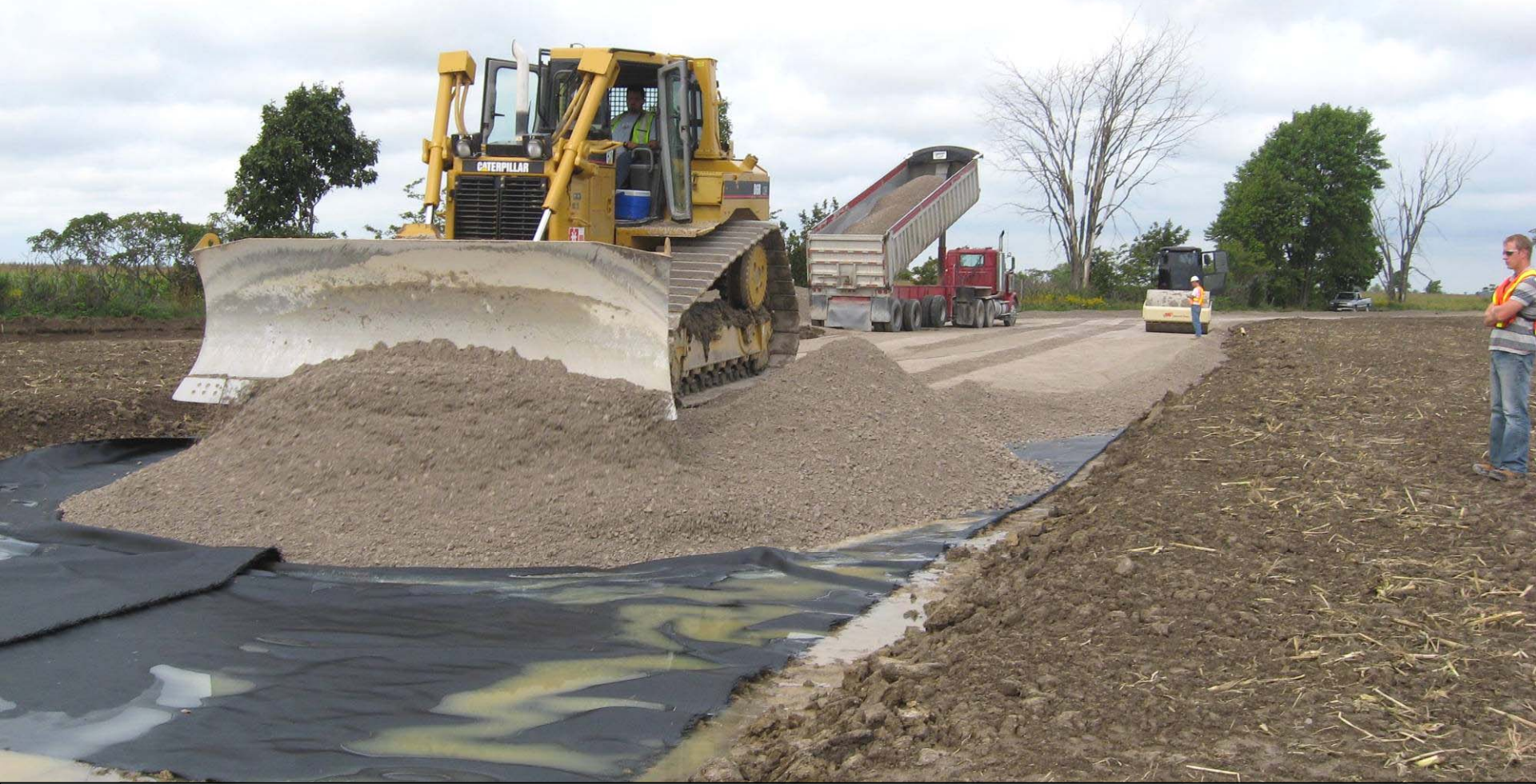
Routes – Étendage et compactage du gravier
