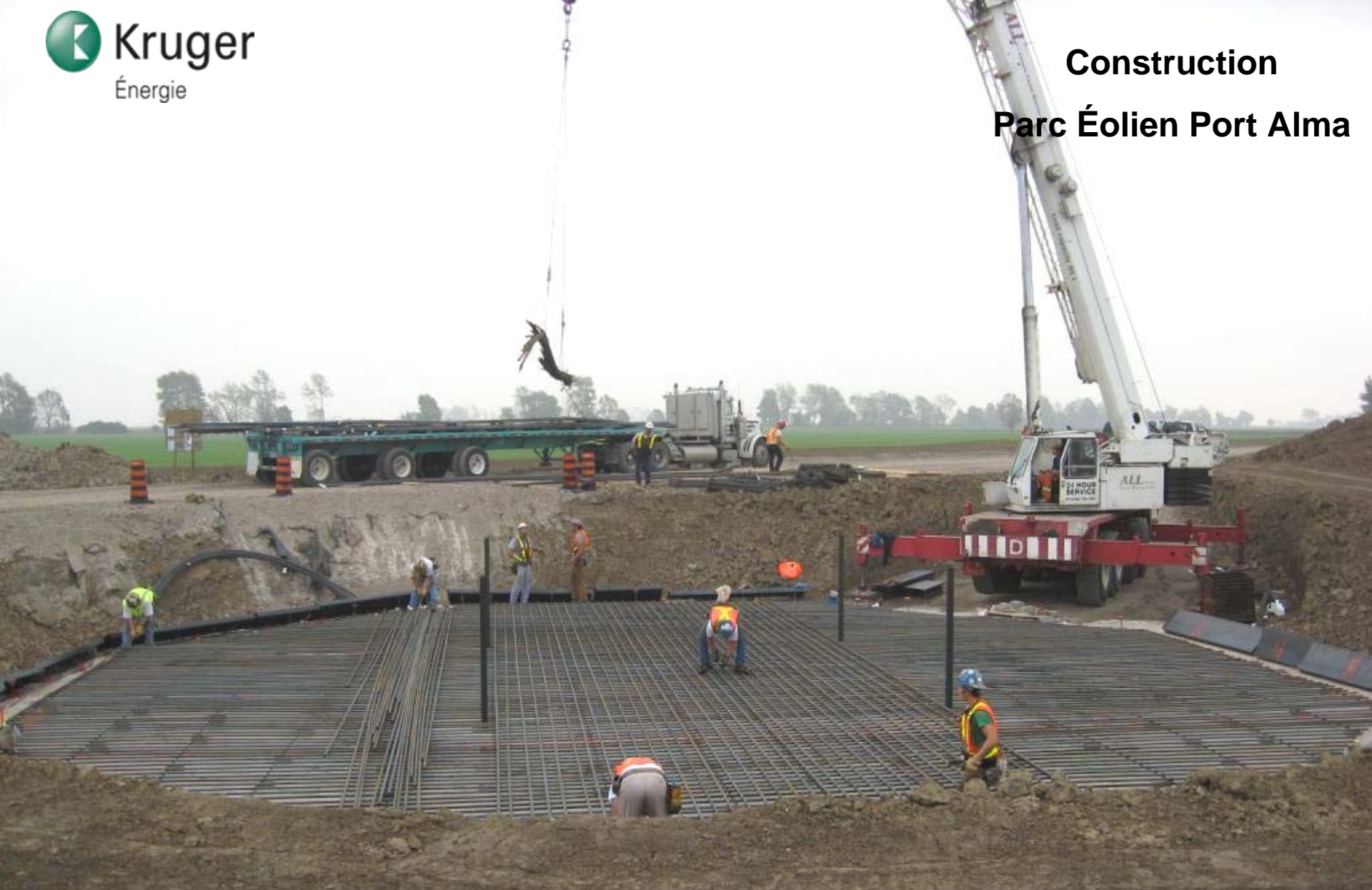
Fondation des éoliennes– Installation des barres d'armature
