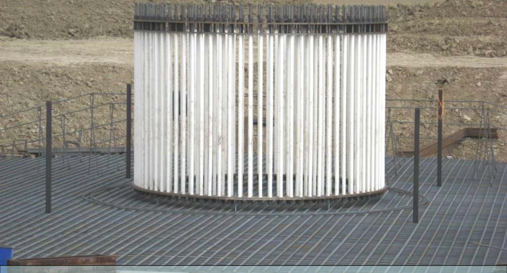
Fondation des éoliennes – Assemblage boulon d’ancrage
