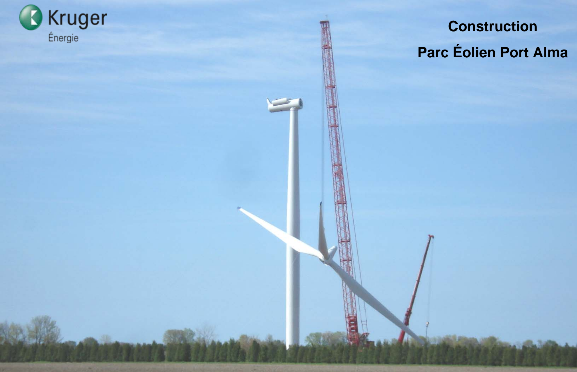
Levage du rotor
