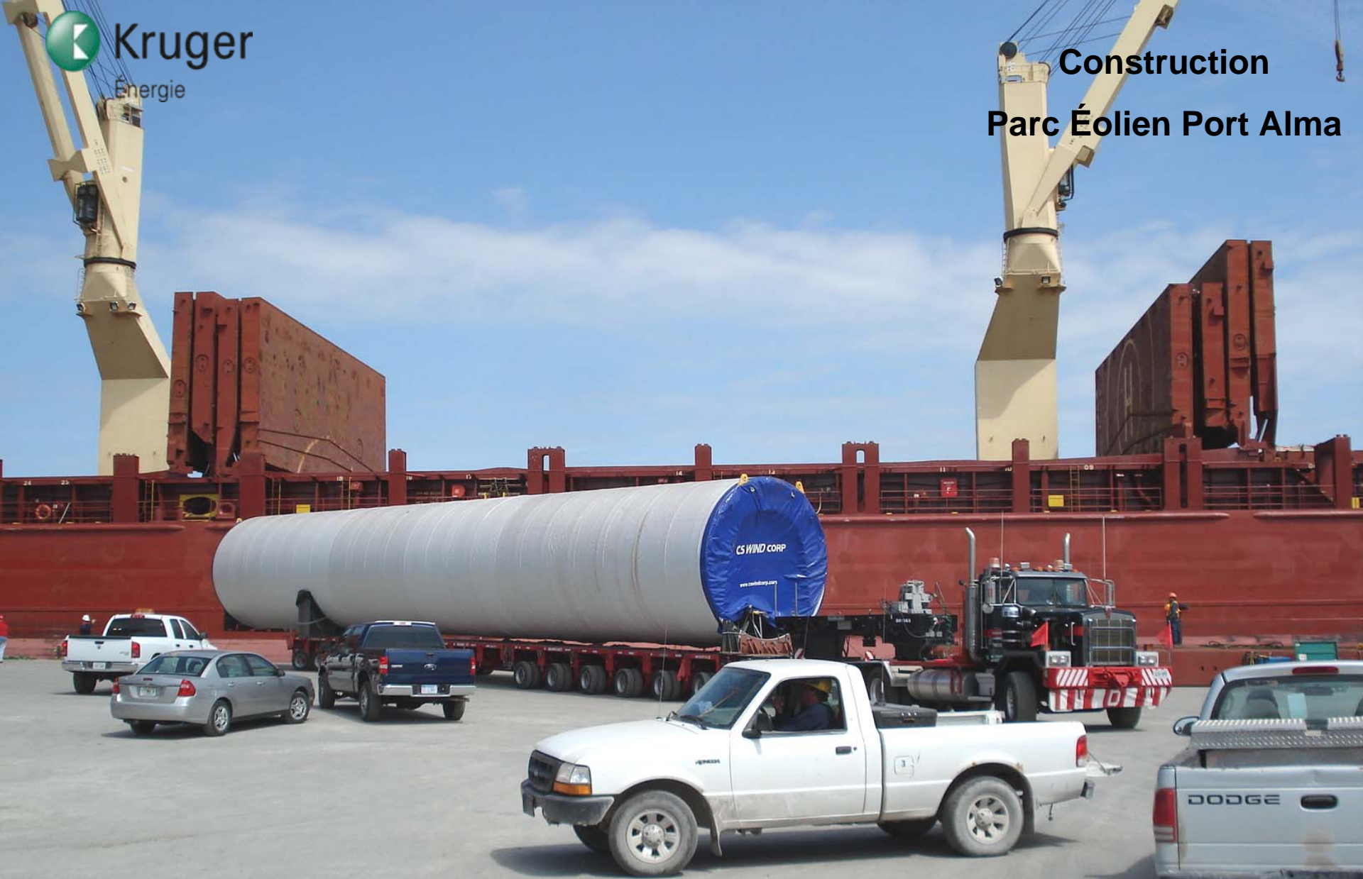
Section de tour déchargée d'un bateau
