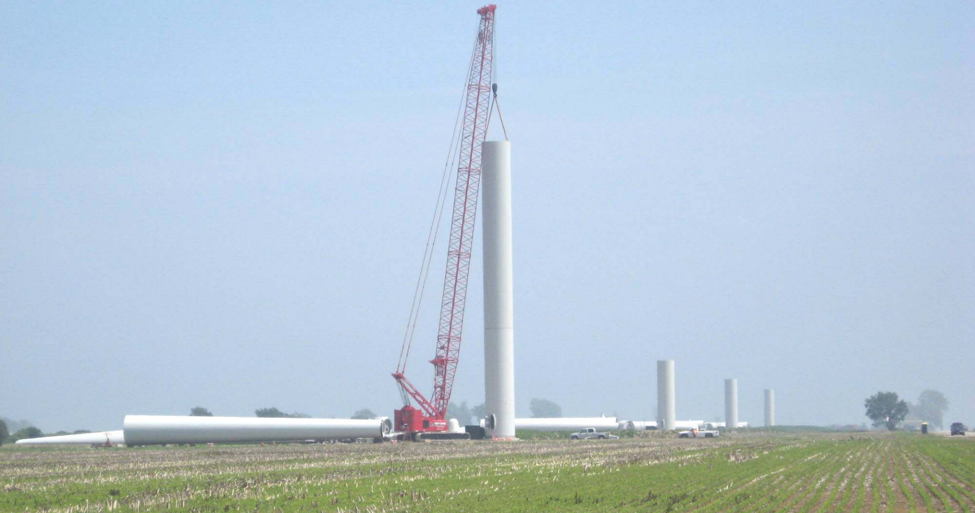
Levage d'une section intermédiaire de tour
