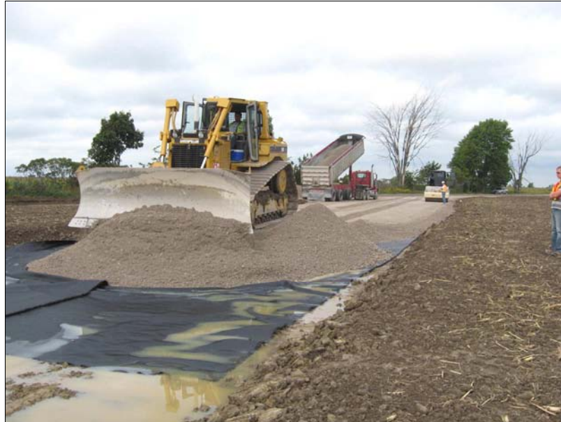
Figure 3.11 Construction des chemins d'accès
