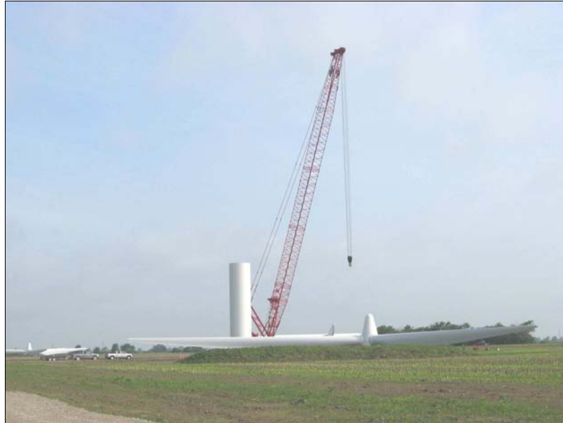
Figure 3.8 Grue et composantes éoliennes en cours d'assemblage
