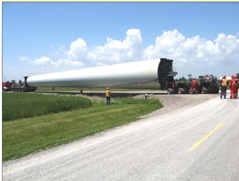
Figure 3.2 Transport de la section supérieure de la tour
