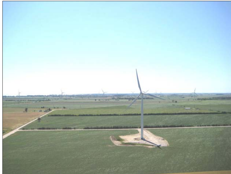
Figure 3.3 Aire de travail suite à l'érection de l'éolienne, avant la remise en état
