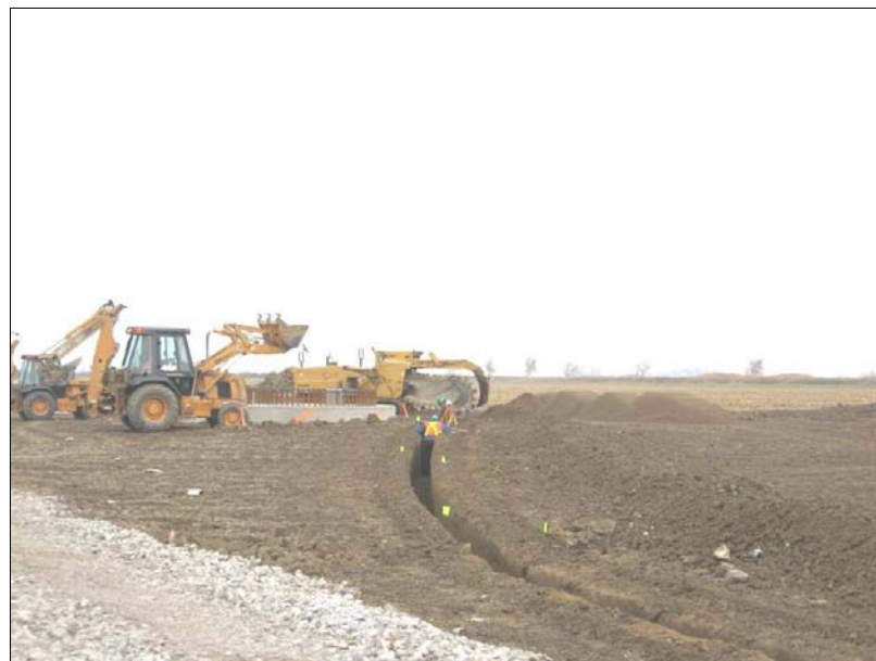
Figure 3.13 Creusage de la tranchée pour le réseau collecteur
