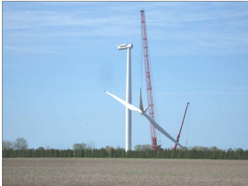
Figure 3.9 Montage du rotor
