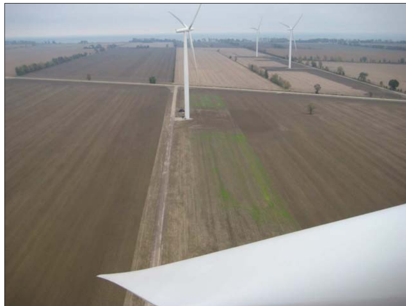
Figure 3.4 Aire de travail à la suite de l'érection de l'éolienne, après la remise en état
