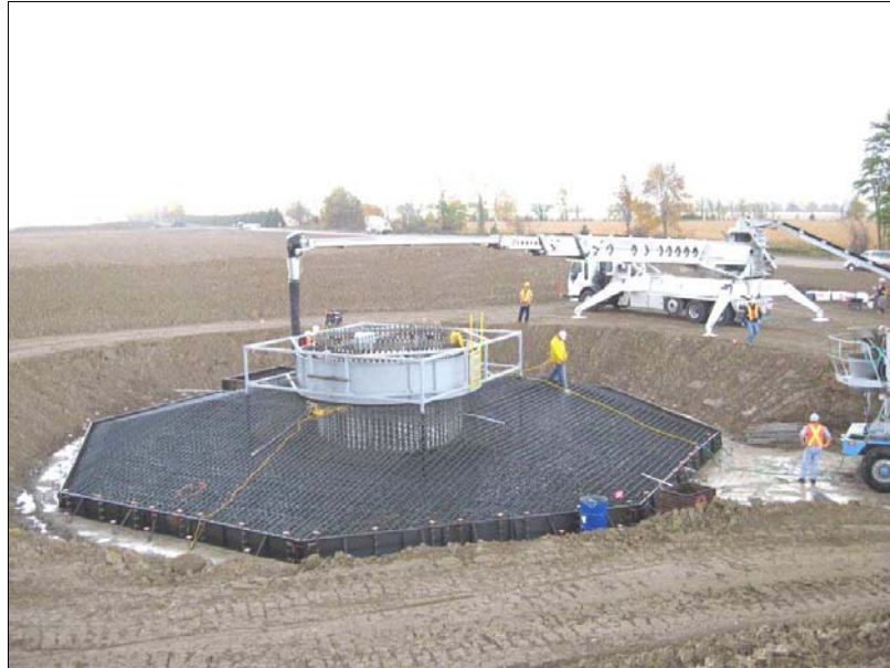
Figure 3.7 Fondation type d'une éolienne
