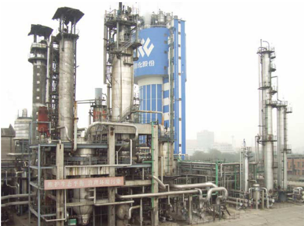
Photographie d'une usine d'urée de la compagnie Toyo. 35
