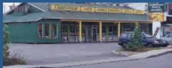
Accès de commerce
