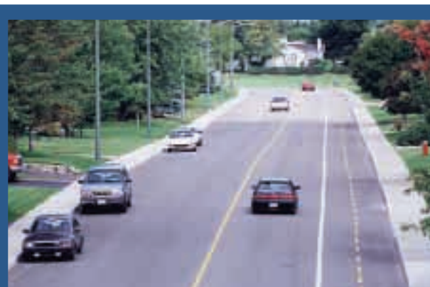
Ici, la largeur de la surface pavée comporte les deux voies de circulation, une allée de stationnement ainsi qu'une bande cyclable
