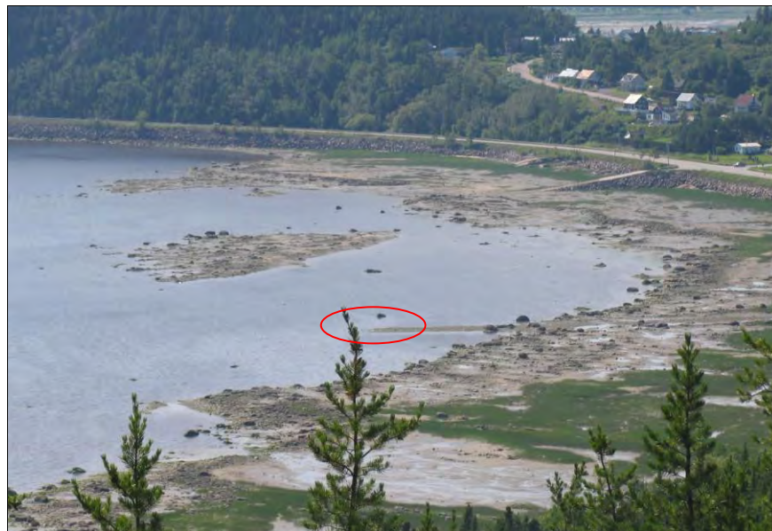
Figure 26. Exutoire sanitaire, municipalité de Saint-Fulgence.
