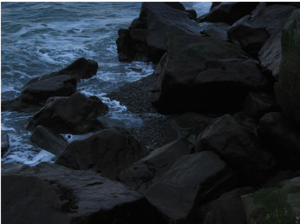
Photo 2 Poche de gros graviers (de 25 à 75 mm) située à l'étiage sur le brise-lames
