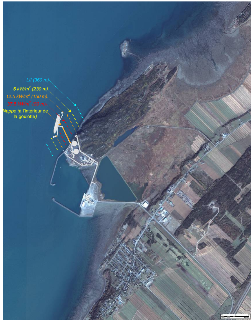
Figure 9.4-3 Illustration d'une fuite de ligne de déchargement
