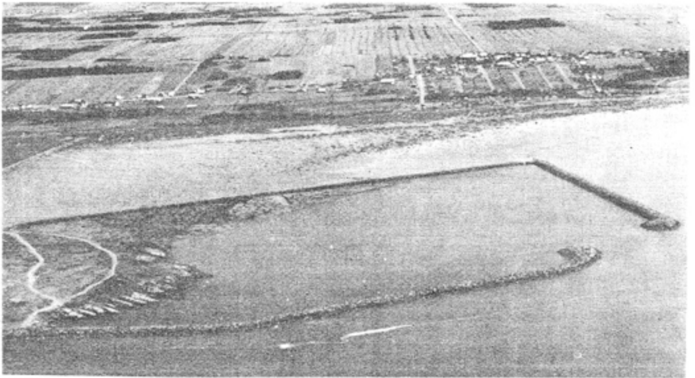
Cette photographie aérienne fait voir les travaux de construction des brise-lames et de dragage du bassin, terminés en 1969. .
