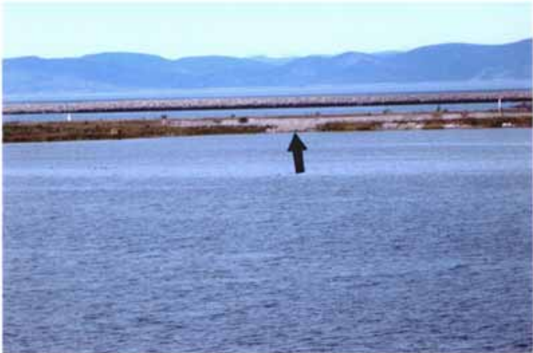
Digue nord-est du bassin ouest. Secteur instable (brèche-ouverture) Référence: DM 29.1 P12 Système hydraulique des plans d'eau DM 29.3 Travaux d'urgence Photos: Gerard Michaud . 25/08/06 08:17
