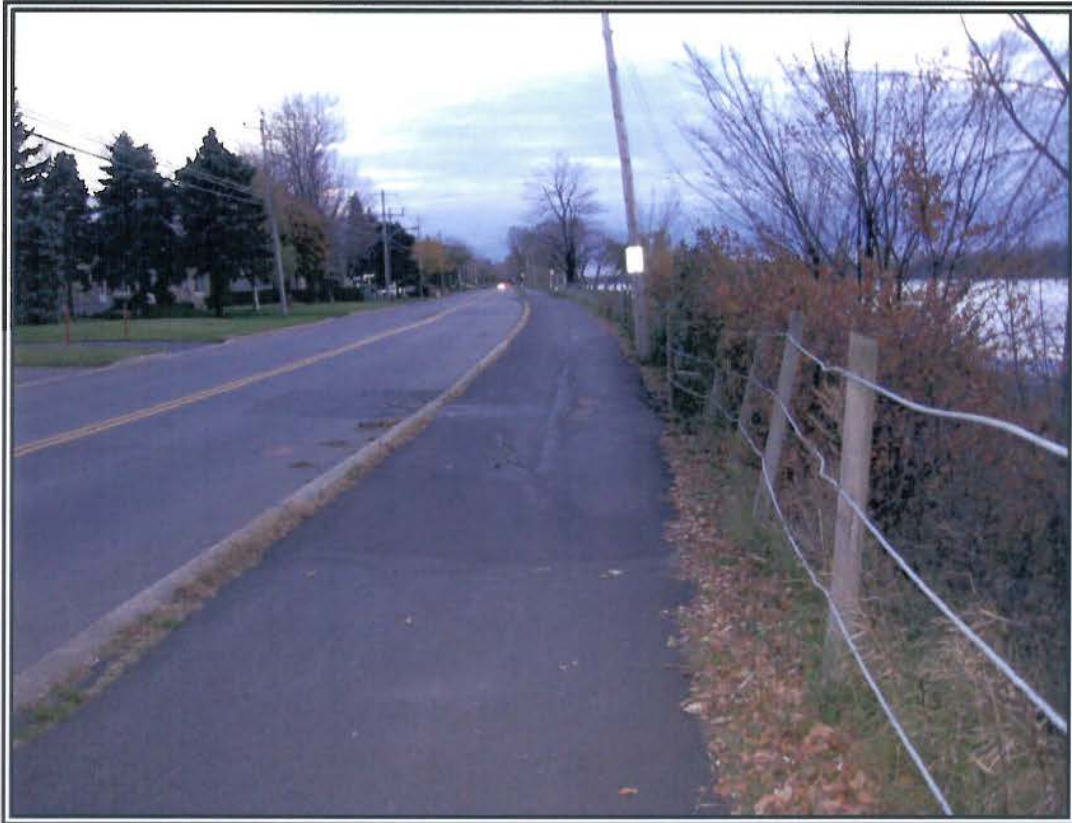
Photographie no 3: Secteur des forages F-02 et F-03, vue de la piste cyclable vers le sud-ouest.
