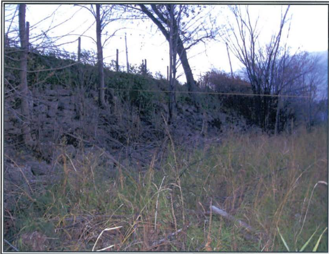
Photographie no 5: Secteur des forages F-02 et F-03. Remblai du talus en bordure de la piste cyclable.
