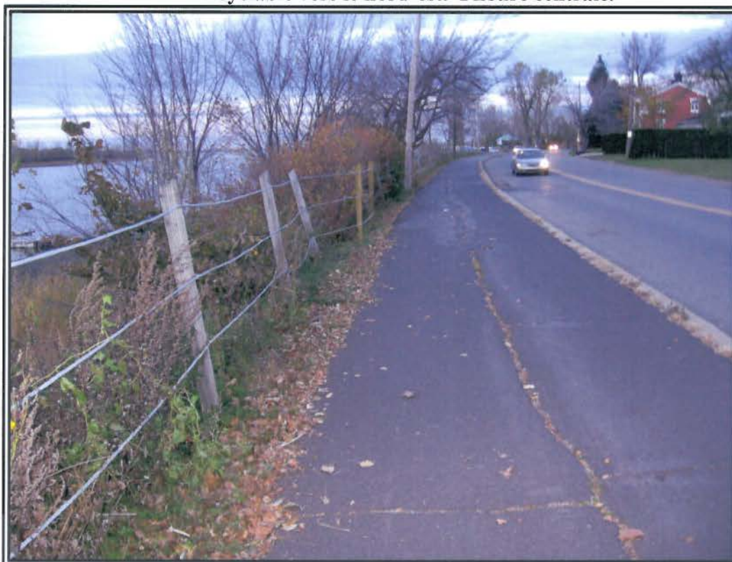
Photographie no 8: Secteur des forages F-04 et F-05. Vue vers le nord-est. Fissure centrale et inclinaison de la clôture vers le fleuve.
