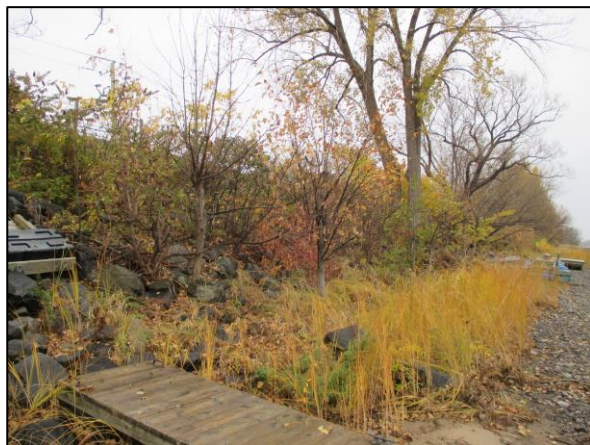
Photo 1 : Exemple d'arbres de moins de 20 cm de DHP colonisant le bas de talus existant qui devront être abattus (tronçon 2).
