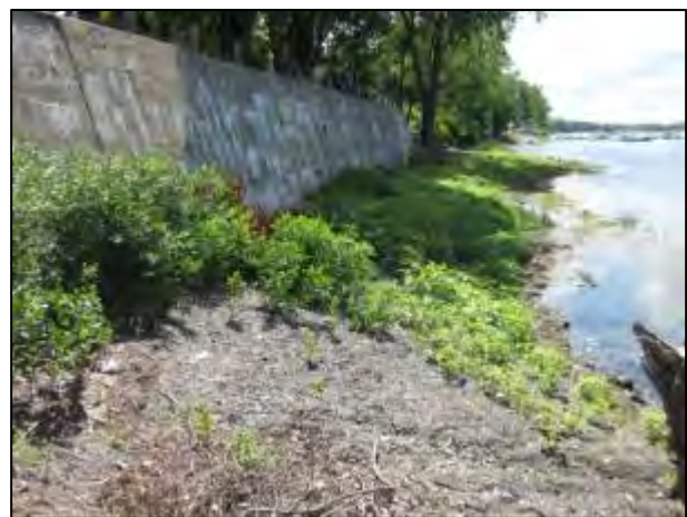
Figure 7. Aperçu du tronçon 4.
