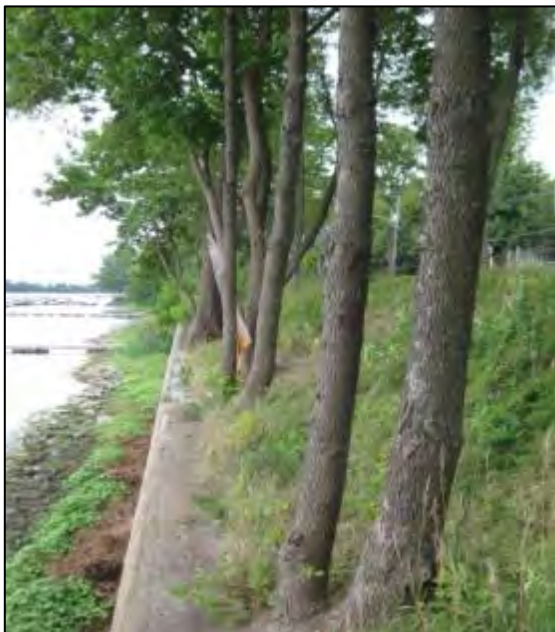
Figure 4. Aperçu du tronçon 1.
