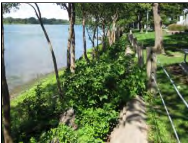
Figure 6. Aperçu du tronçon 3.
