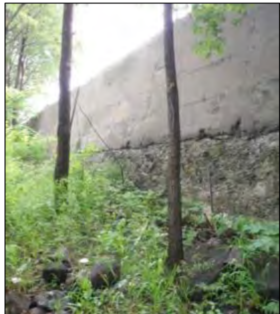
Figure 5. Aperçu du tronçon 2, en amont de la zone d'accès au quai (Génivar 2010).
