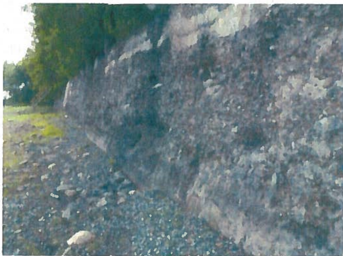
Photo 1 : Muret entre le quai De Montarville et la marina
