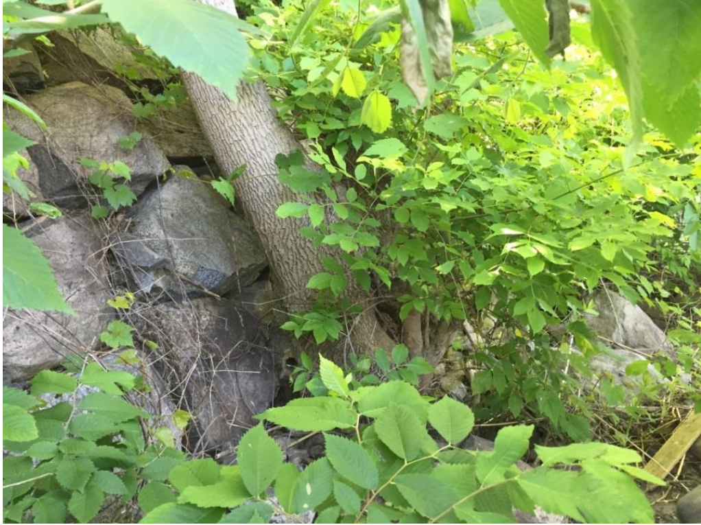
Base du muret de pierres dans le parc Joseph-Laramée (15 juin 2016)
