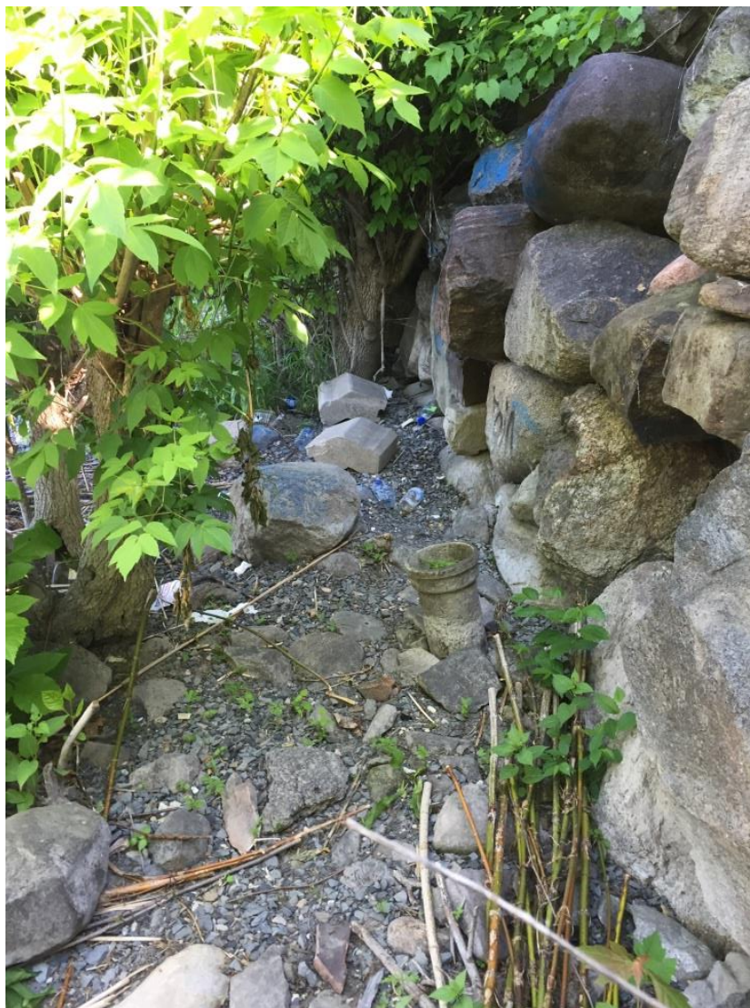
Base du muret de pierres dans le parc Joseph-Laramée (15 juin 2016)
