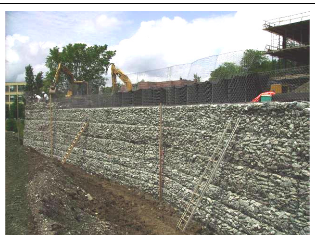
Exemple de mur en Gabions
