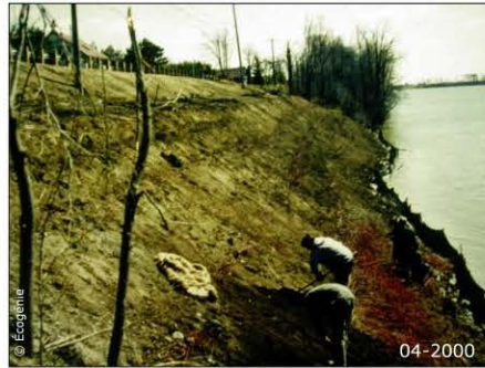
Installation de plançons dans le talus et fagots en pied de talus
