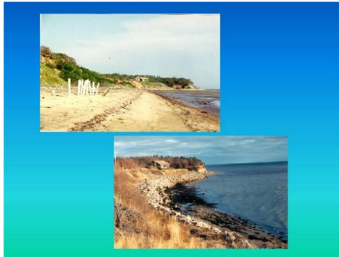
Empierrement: affouillement et disparition de la plage après 2 ans
