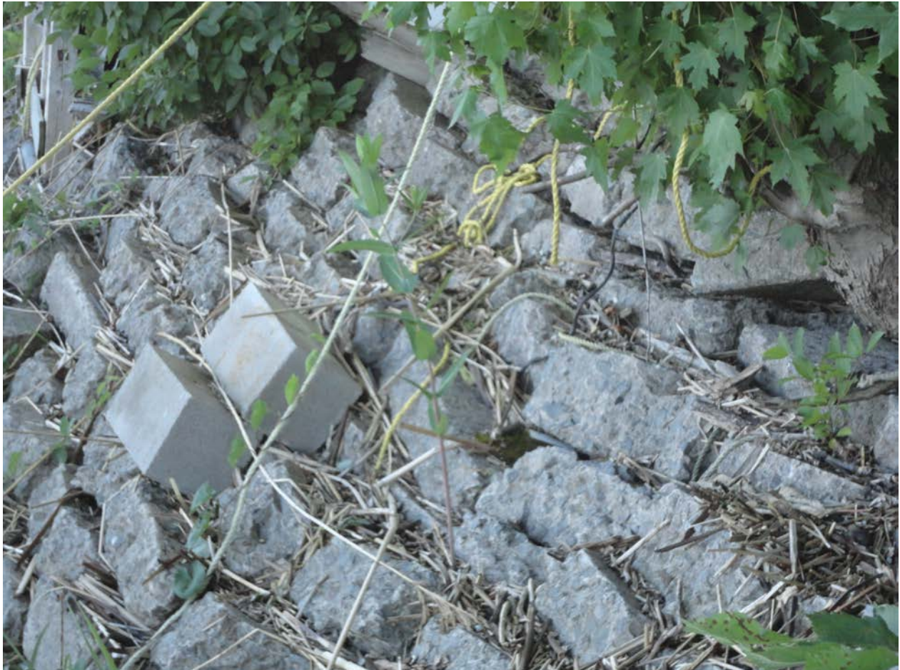
Photo-1 – blocs de béton
