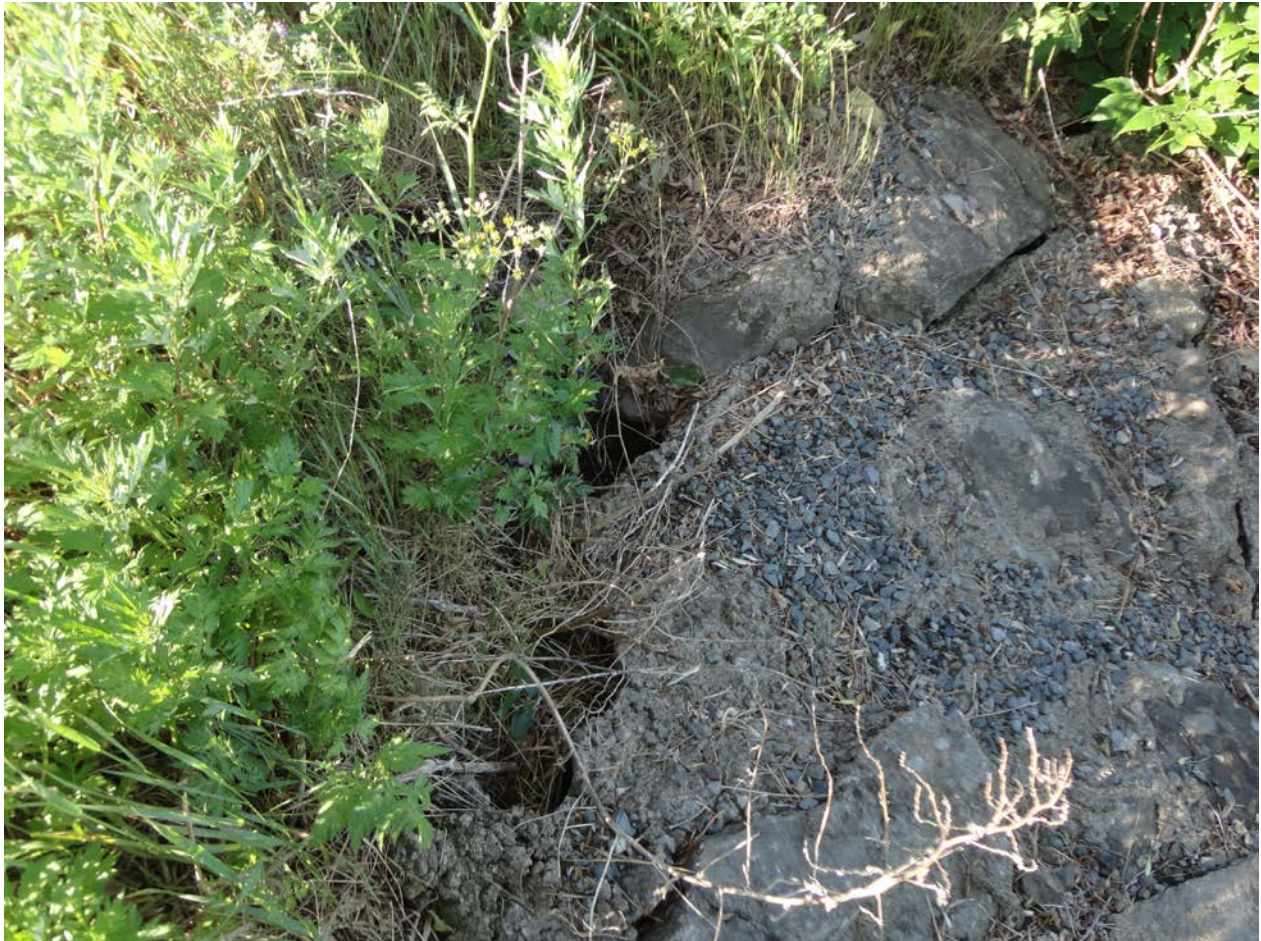
Photo-4 – Trous provoqués par le gel/dégel en bordure de la piste cyclable
