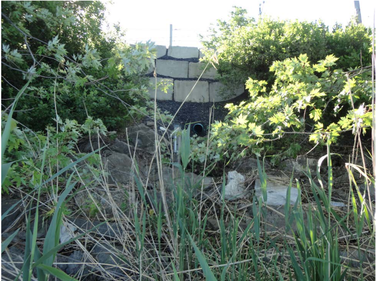
Photo-2 – Vue d'un égout fluvial
