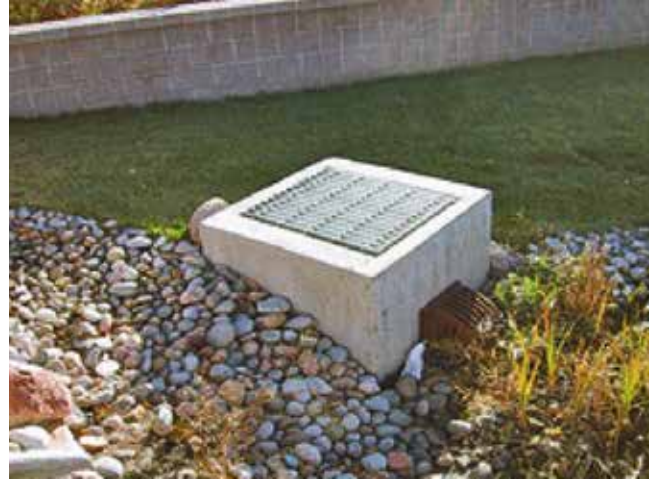
b. Ouvrage de sortie avec une grille.
