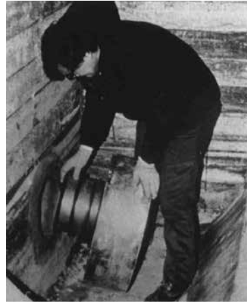
Figure 7.39 Exemple de restricteur de débit avec vortex pour contrôle dans un puisard.
