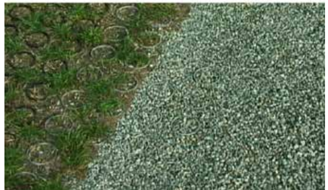
Figure 11.42 Système de pelouse renforcée (GVSD, 2005).
