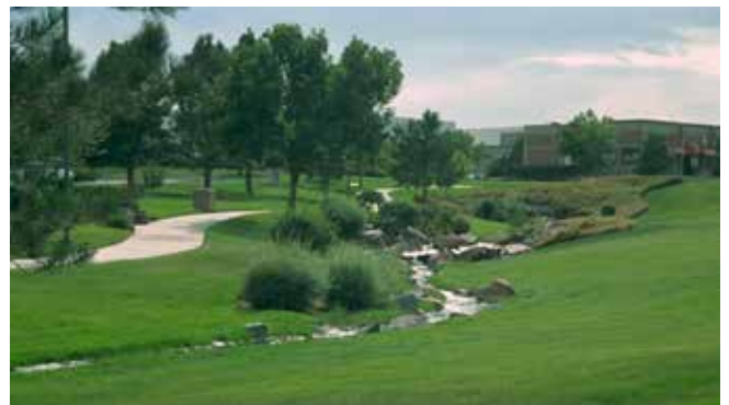
Figure 5.4 Illustration d'un canal à ciel ouvert faisant partie du réseau majeur.
