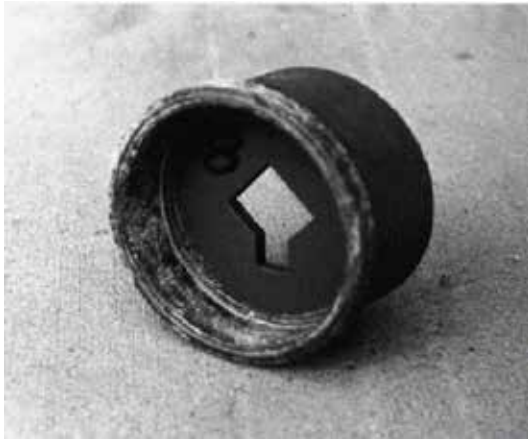
Figure 7.38 Exemple de restricteur de débit avec bouchon en plastique pour contrôle dans un puisard.
