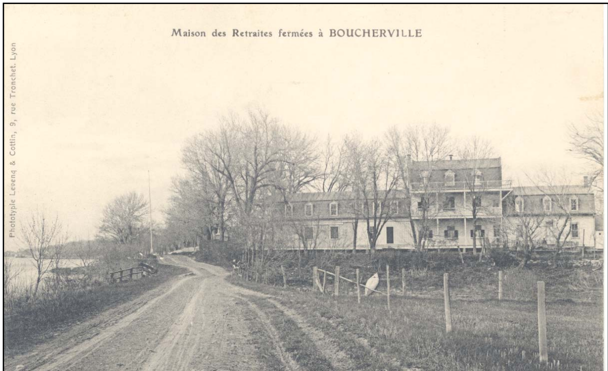
Figure 32 : Maison des retraites fermées à Boucherville (Archives des Jésuites du Canada, R-0002-5, 2)
