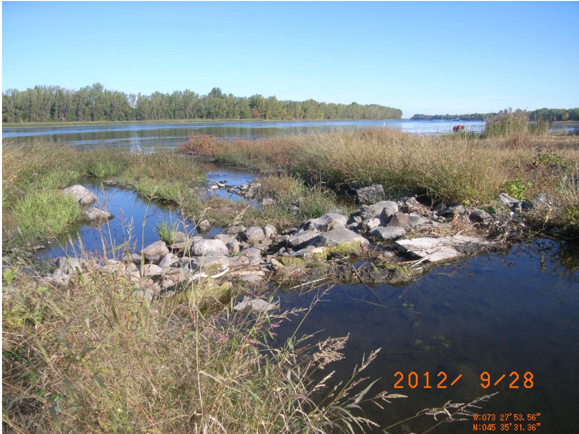
Photo 7 Seuil à l'entrée de la fosse en période d'étiage en 2012 – circulation du poisson problématique.
