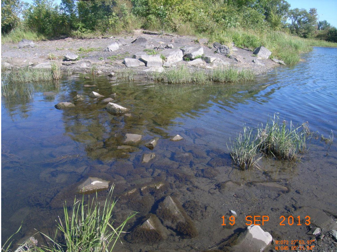
Photo 8 Seuil à l'entrée de la fosse en période d'étiage en 2013 – circulation du poisson encore possible.
