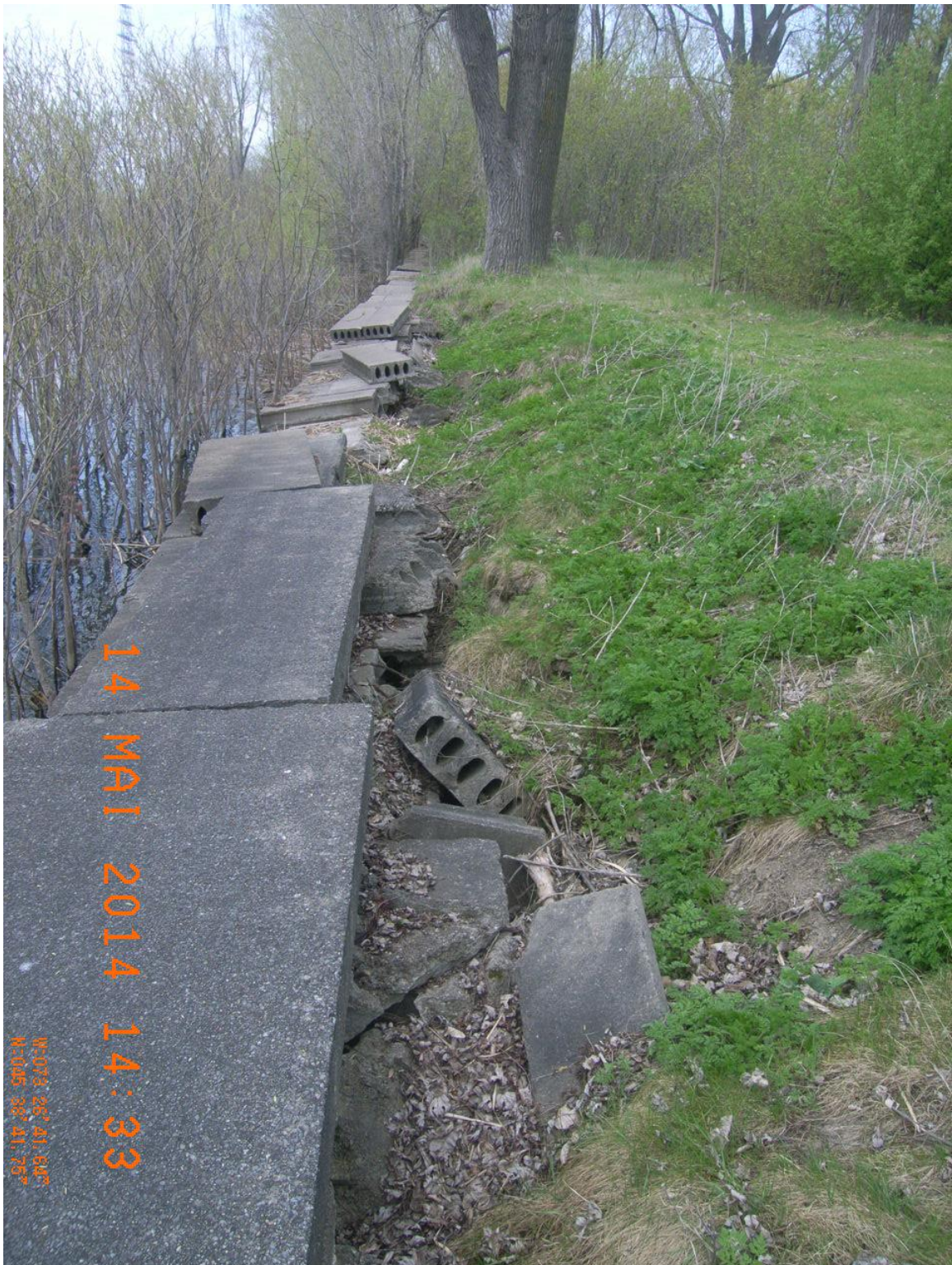
Photo 9 Muret au parc de la Saulaie - vue vers le nord.
