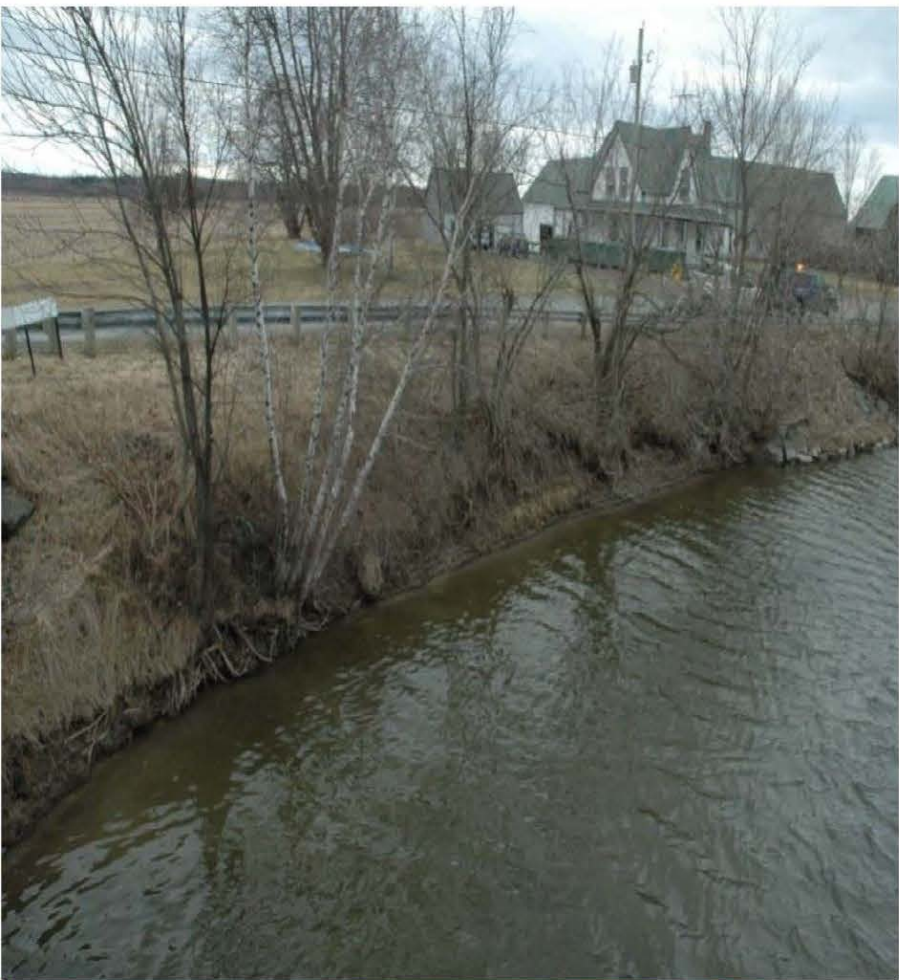
Avant la renaturalisation
