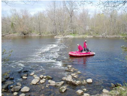
Seuil en empierrement (section 80)
