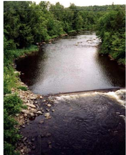
Seuil de béton de Magnola (section 72)
