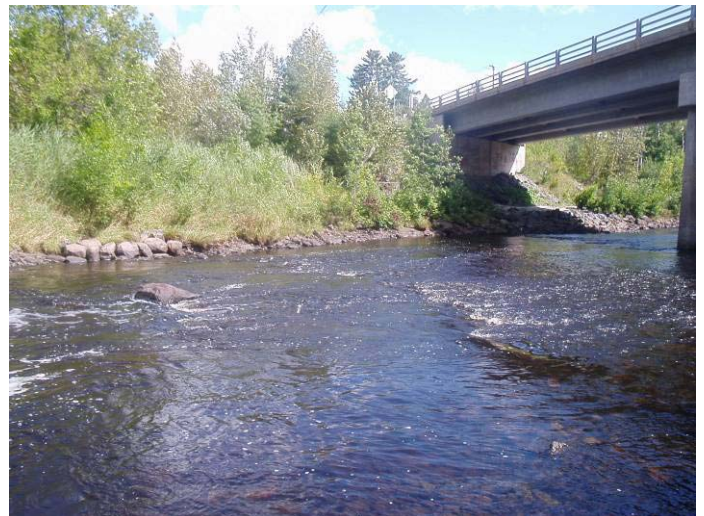
Photo 27 : Vue sur le pont de la route 249, juin 2006
