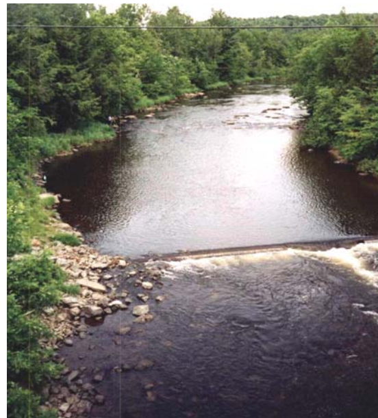
Photo 36 : Petit seuil de béton érigé au niveau du pont de la route 249 dans la rivière Nicolet Sud-Ouest
