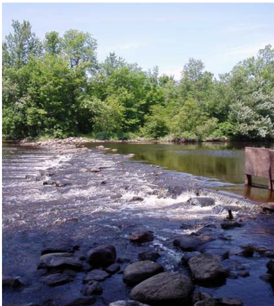
Photo 35 : seuil en empierrement à l'exutoire du lac
