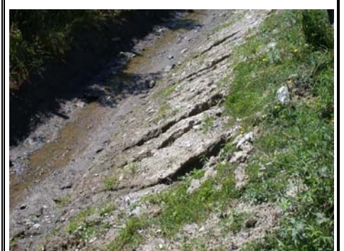
Pt 31: Ravinage du fossé
