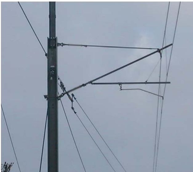
Figure 3.9 - Montage normal d'une console
