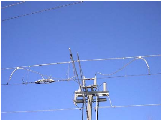
Figure 3.23 - Pontage éventuel d'un isolateur
