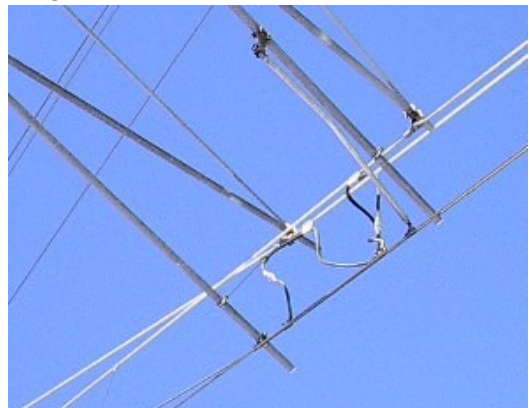
Figure 3.24 - Connexion de continuité
