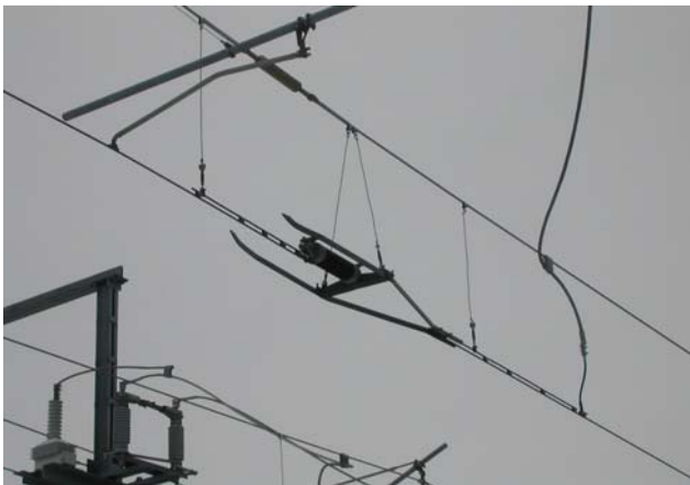
Figure 3.19 - Exemple d'isolateur (Isolateur à masse concentrée)
