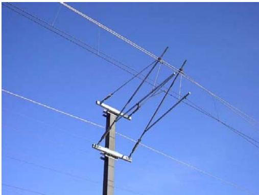
Figure 3.10 – Montage avec 2 consoles
