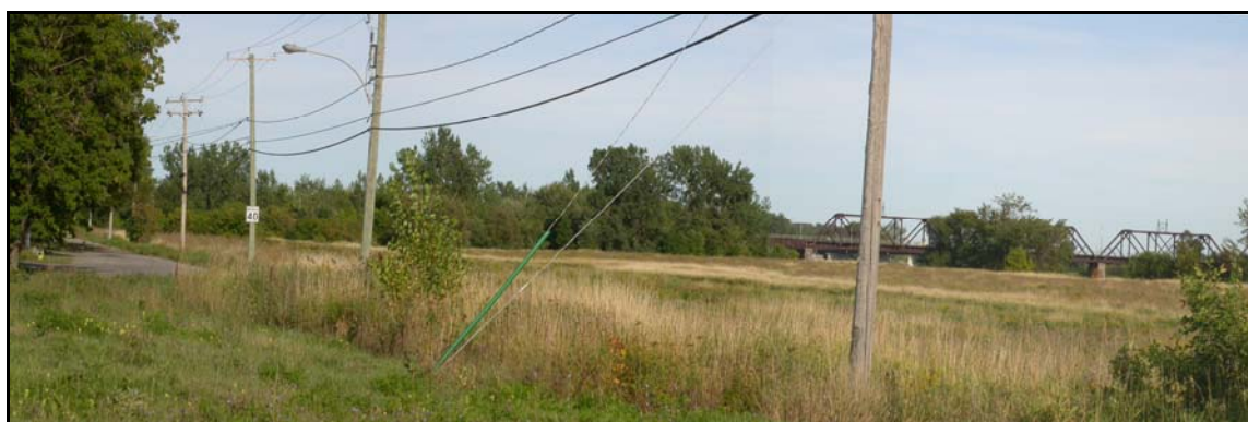
Photo 3 : Vue panoramique sur la zone humide qui longe la rivière des prairies et sur le pont du chemin de fer existant (sous-unité A3)
