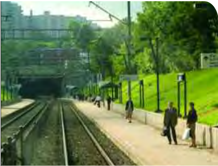
Vue du tunnel du Mont-Royal
