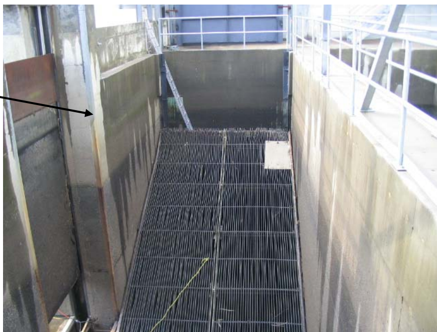
Photo 3. Une des 2 grilles inclinées installée à Sainte-Anne (pendant mise hors d'eau)
