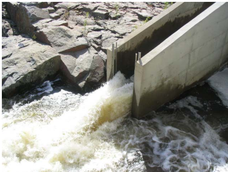
Photo 2. Extrémité du système de dévalaison de la centrale Sainte-Anne
