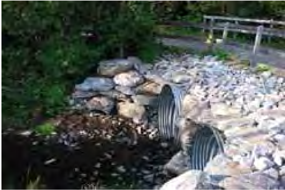
Figure 7-58 : Exemple de construction avec remblai et ponceaux
