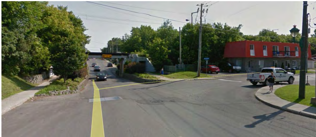
Figure 7-25 : Ouvrage d'art - pont d'étagement - chemin d'Oka
