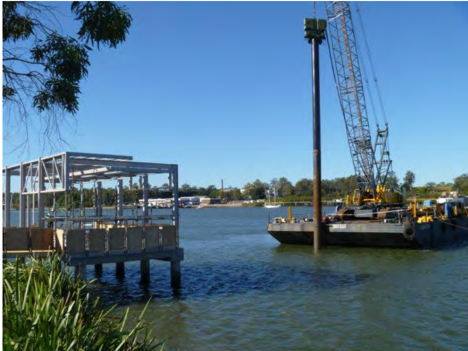
Figure 7-55 : Exemple de construction avec barge pour forage de pieu (Northshore, Hamilton)
