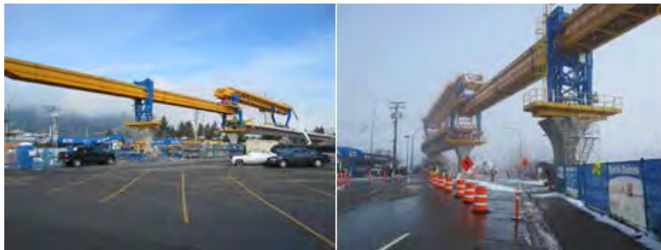
Figure 7-46 : Technique envisagée pour la pose des voussoirs
