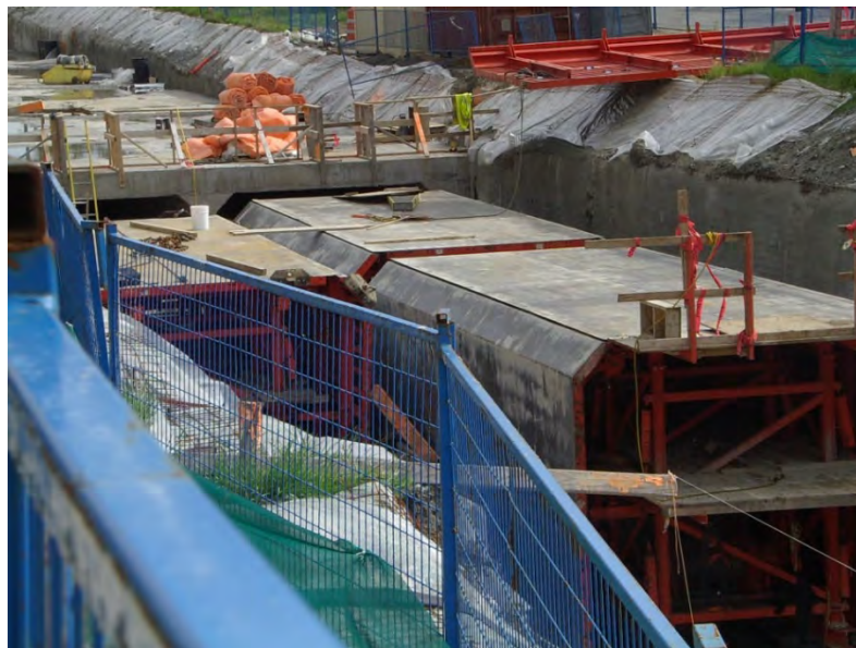
Figure 7-41 : Exemple de configuration en tranchée couverte (2)
