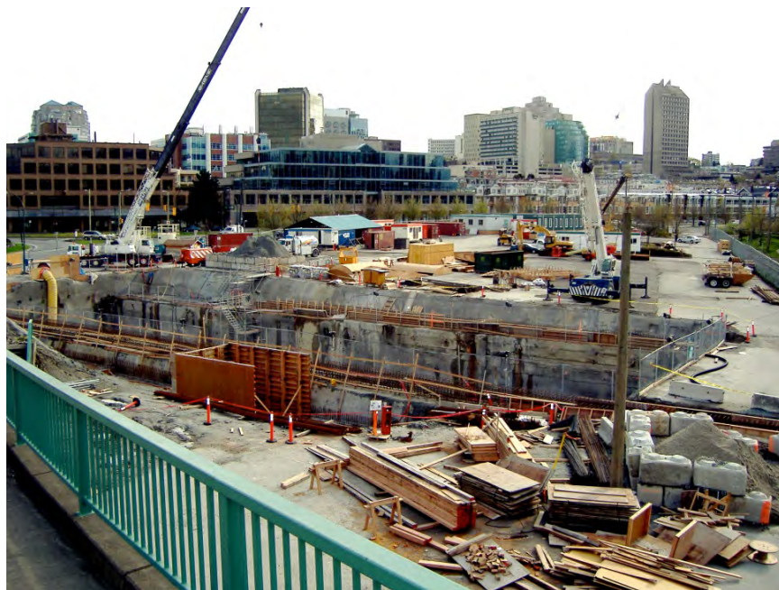
Figure 7-47 : Exemple de construction en tranchée couverte - Skytrain de Vancouver (1)
