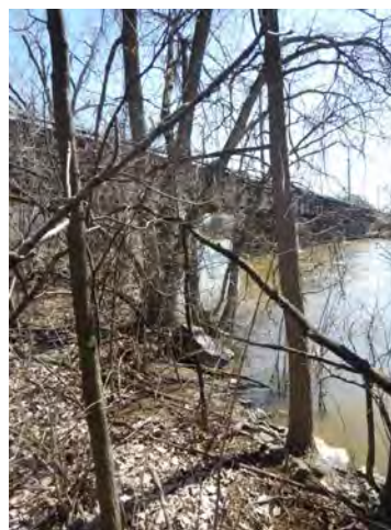
Vue de la rive nord du pont, à l'ouest du rail existant, faisant face à l'est
