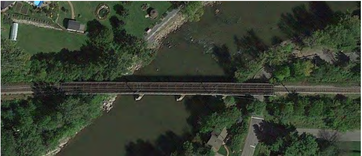
Figure 7-53 : Section 1 - Pont de la rivière des Prairies
