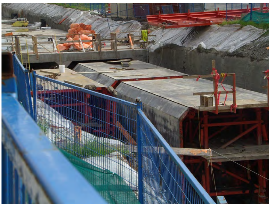
Figure 7-48 : Exemple de construction en tranchée couverte - Skytrain de Vancouver (2)
