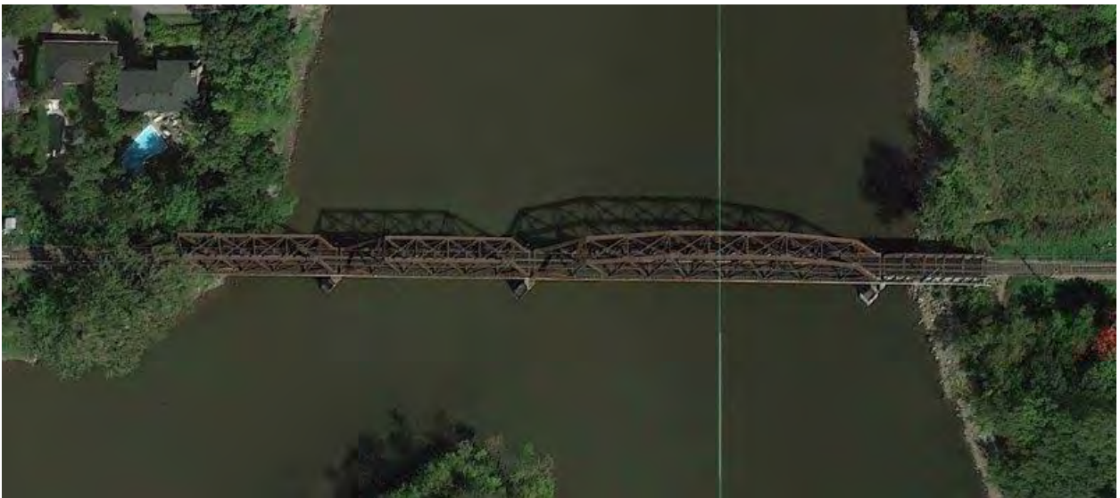
Figure 7-54 : Section 2 - Pont de la rivière des Prairies
