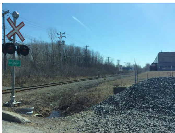
Photographie 5-26 : Option 1b - Voie de chemin de fer existant dans le Technoparc St-Laurent
