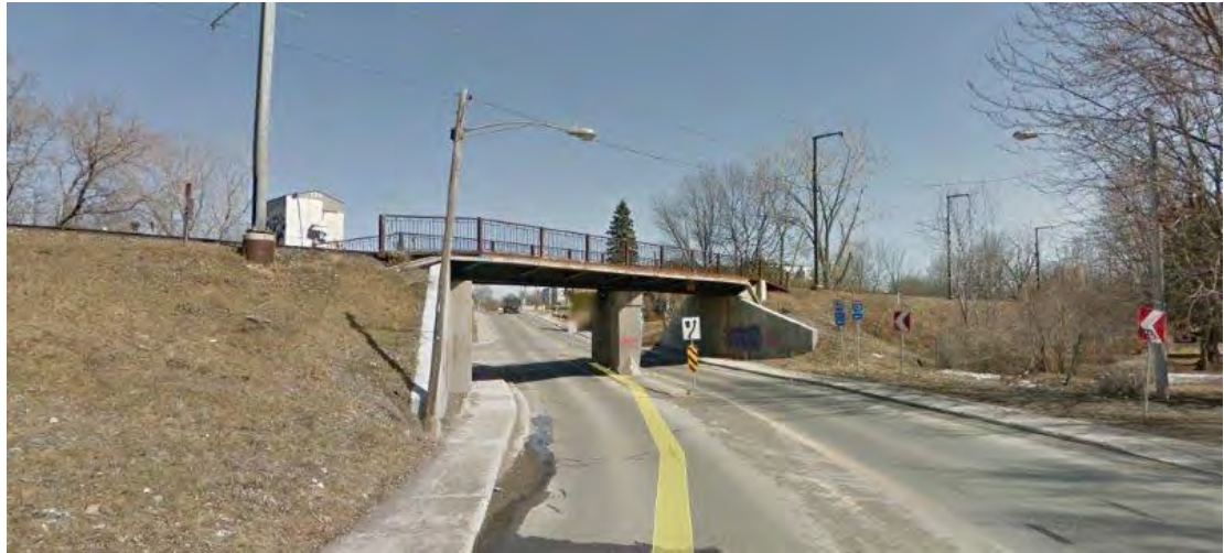
Figure 7-24 : Ouvrage d'art - pont d'étagement rue du Bord-de-l'eau
