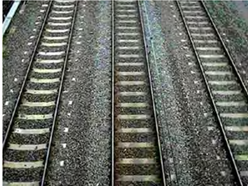
Figure 7-45 : Travaux au sol
