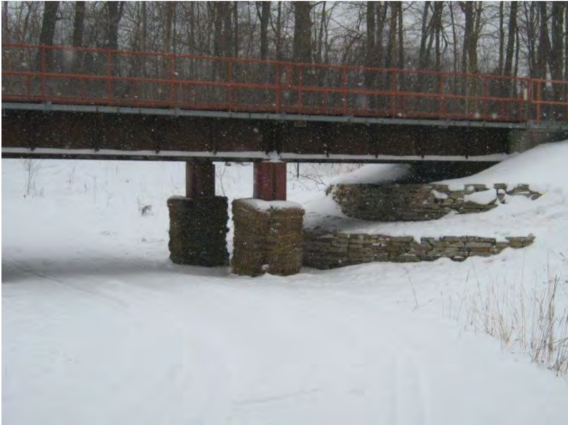
Figure 7-26 : Ouvrage d'art - pont d'étagement - sentier du Bois-de-Liesse
