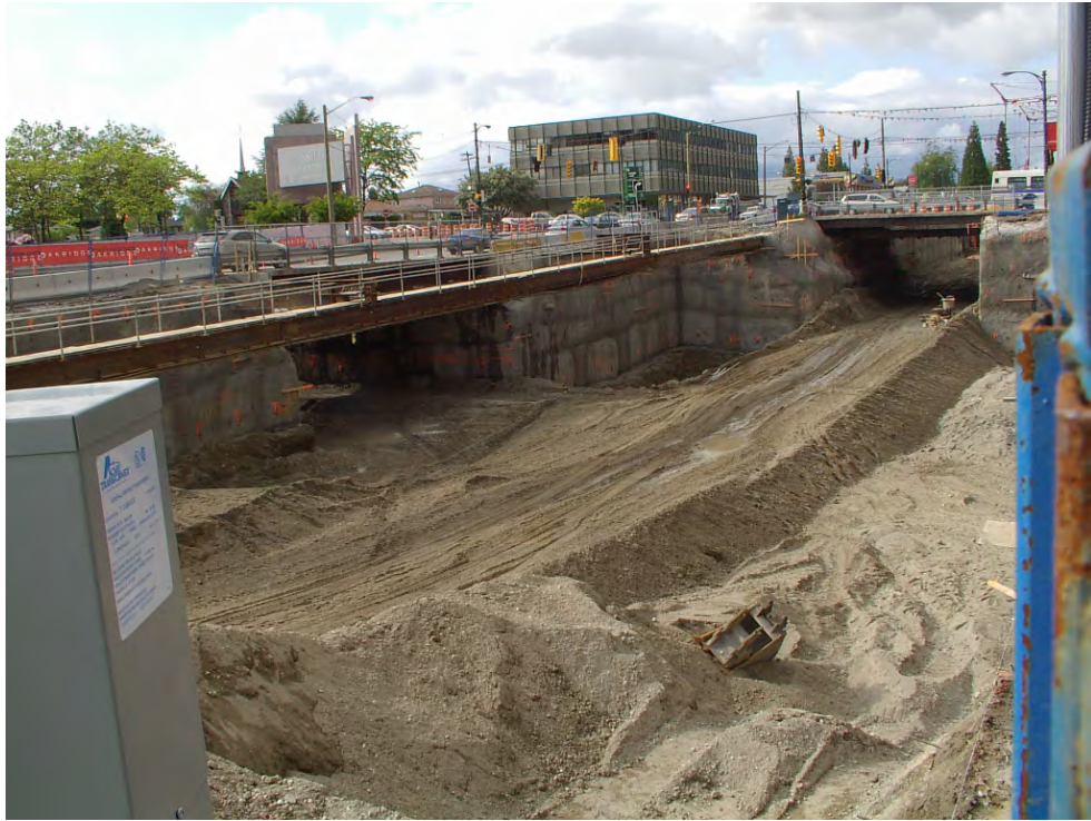
Figure 7-49 : Exemple de construction en tranchée couverte - Skytrain de Vancouver (3)
