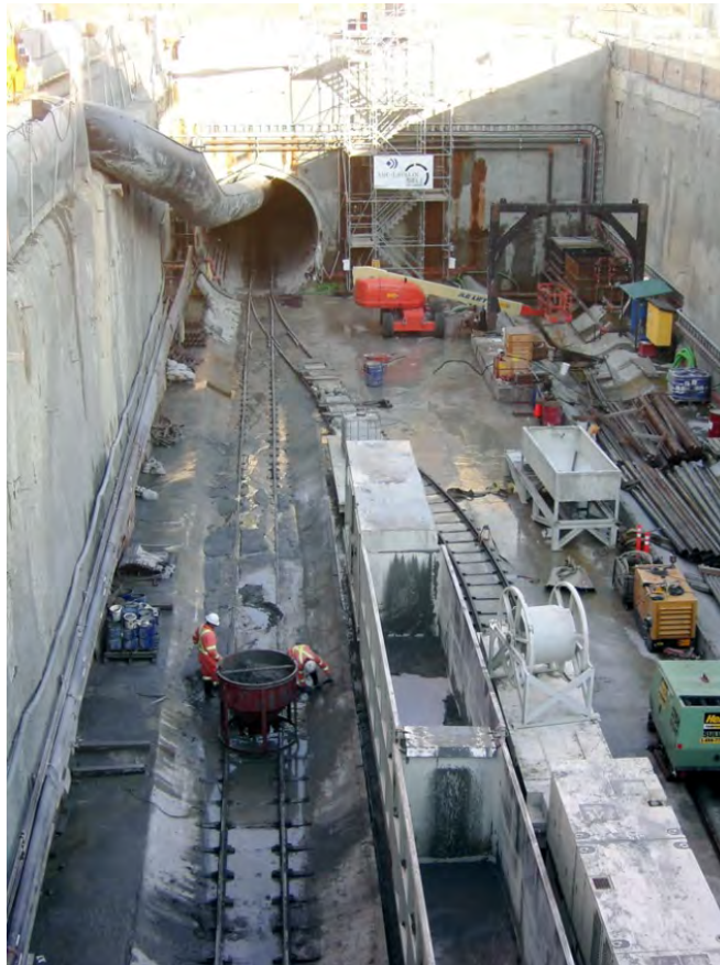
Figure 7-52 : Construction d'un tunnel pour le Skytrain à Vancouver
