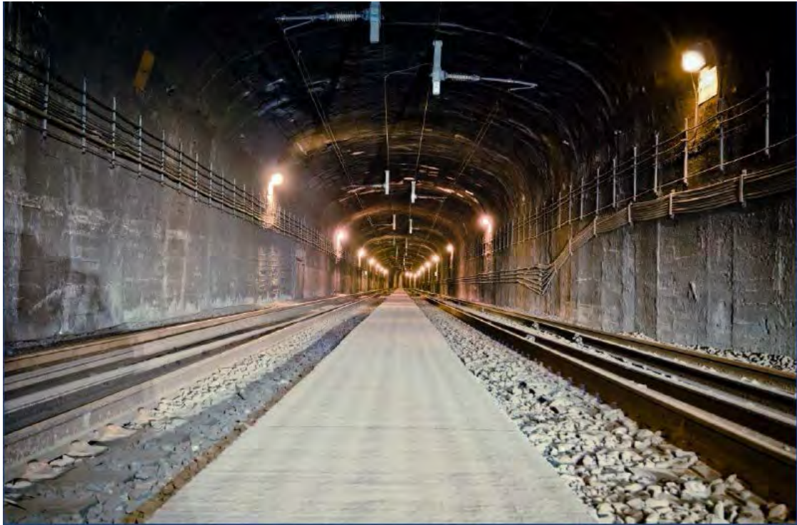
Figure 7-5 : Tunnel Mont-Royal – voûte simple et trottoir d'évacuation central
