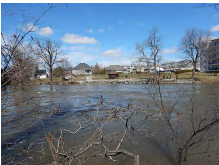
Vue du mur de béton, situé sur la rive nord du pont. Photo prise à partir de la rive sud, à l'est du rail existant, faisant face au nord.
