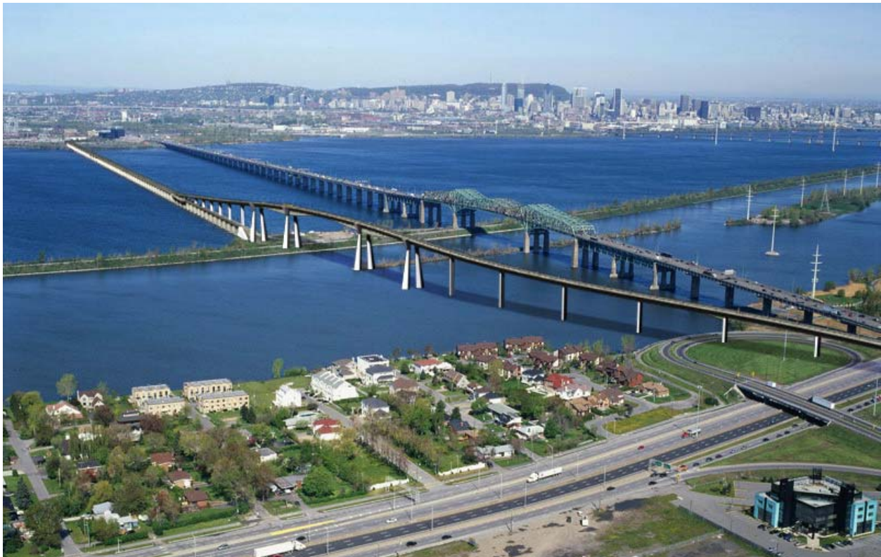
FIGURE 7 - Pont du SLR au-dessus de la Voie maritime
