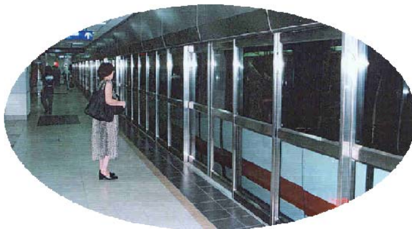
FIGURE 20 - Exemple d'un système de portes palières
