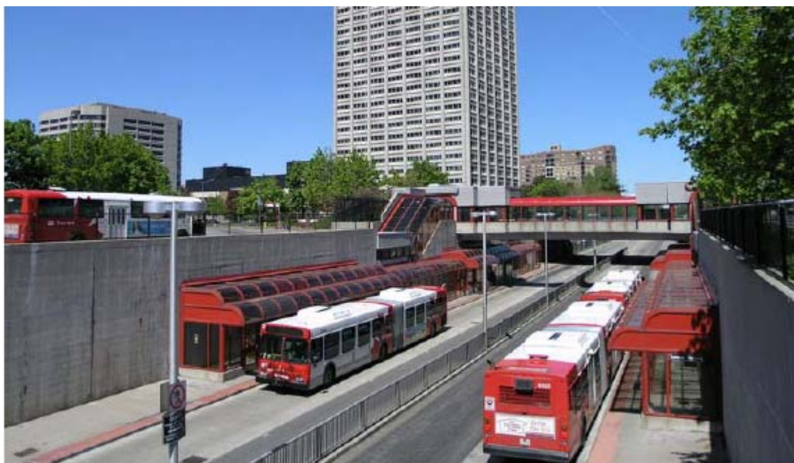
Figure 3-2 Station du Transitway d'Ottawa
