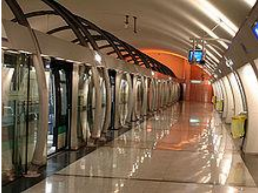
Figure 3 Système de portes palières – Ligne 14 Paris
