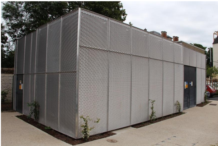
Figure 7 Vue extérieure d'un poste de redressement 750 V – Tramway Orléans – France 2012-06-29
