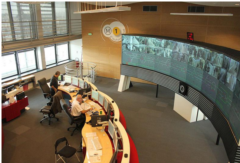
Figure 5 Ligne 1 du métro Parisien – France
