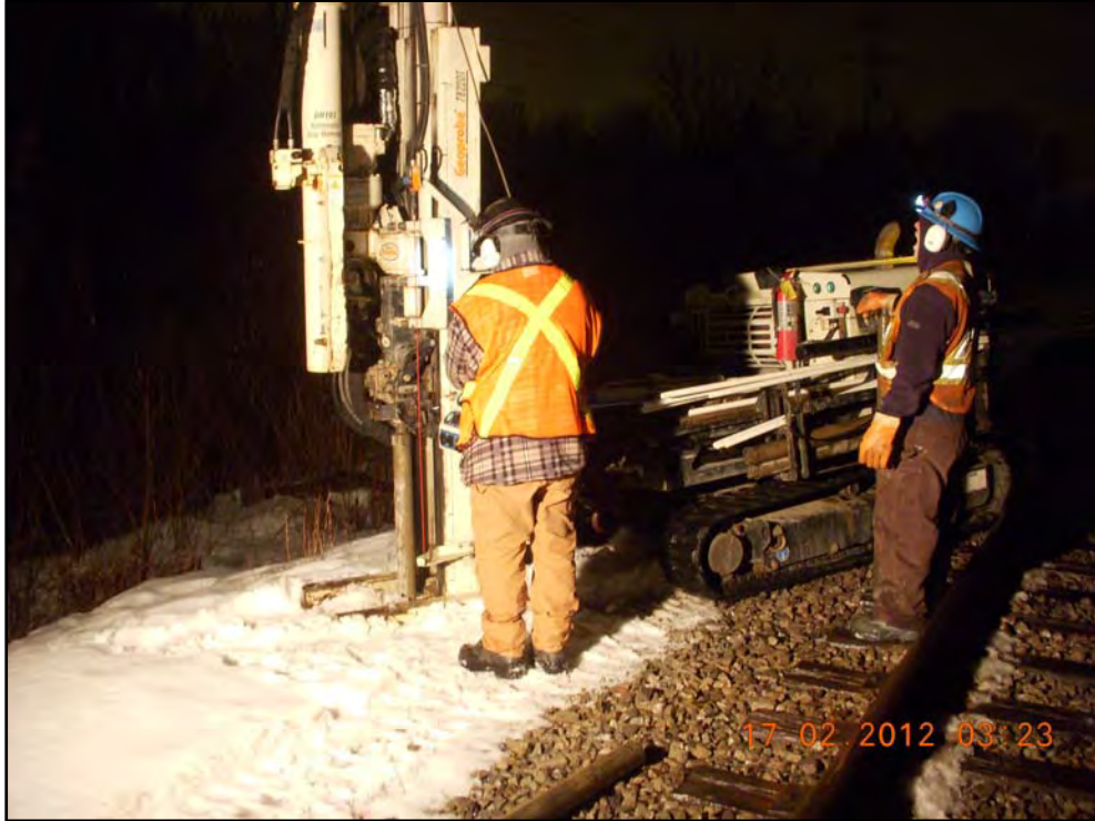
Photographie 1. Exécution d'un forage de nuit (F-10).
