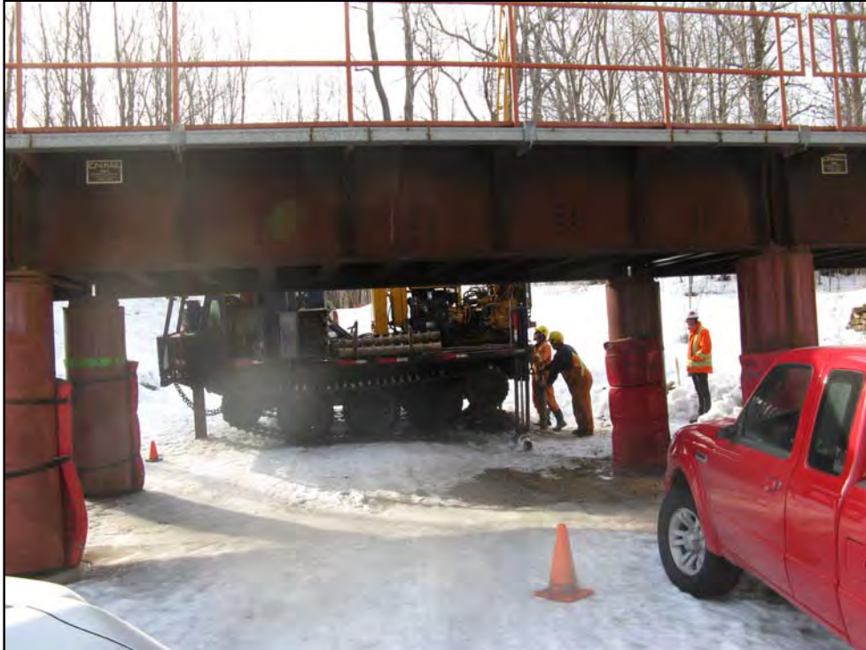
Photographie 5. Forage F-13 et F-14, à la piste cyclable du Parc nature Bois-de-Liesse.
