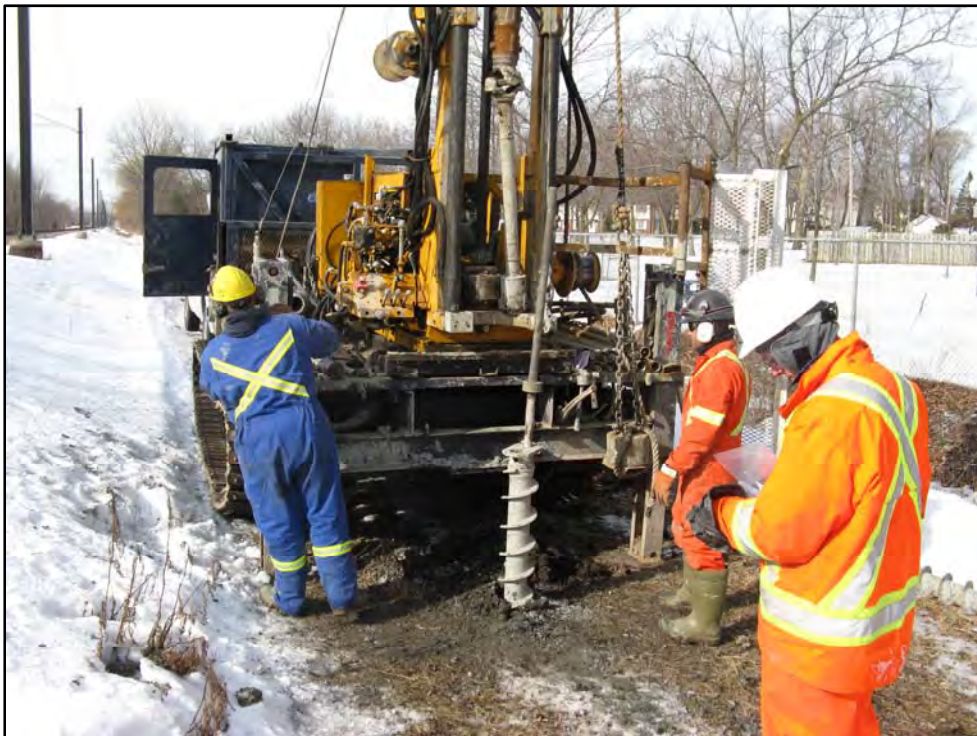
Photographie 4. Forage F-18.
