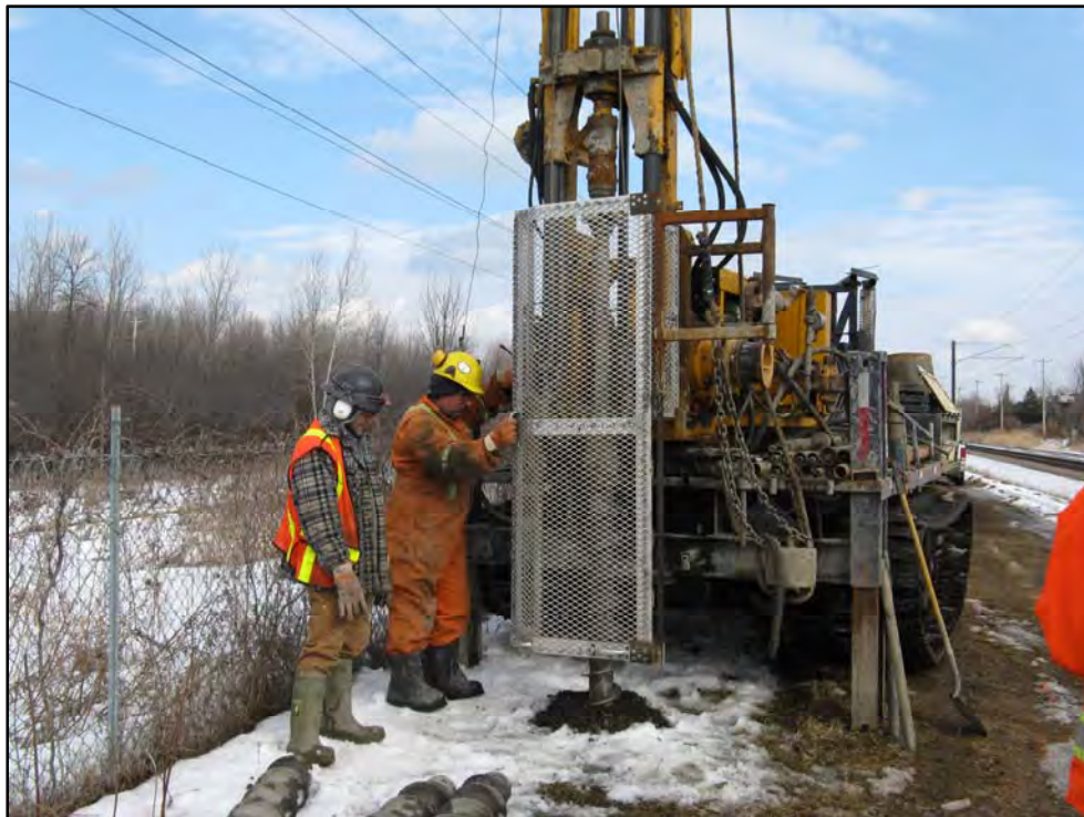
Photographie 2. Forage F-15
