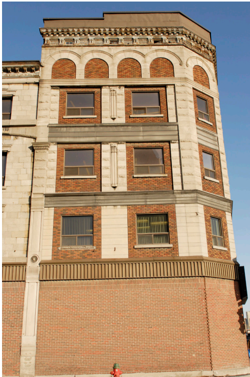
Le bâtiment de coin est la figure de proue de l'ensemble. Il est construit en 1890-1891 suite à l'élargissement de la rue Notre-Dame. Par la suite les ouvertures ont été partiellement obstruées par de la brique et le bâtiment a perdu son couronnement.
