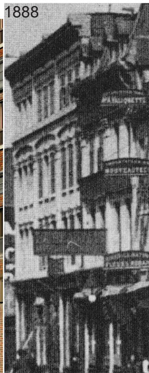
La trace des anciens bâtiments est toujours sensible sur la façade de pierre de taille, en particulier par la différence dans la largeur des travées et le nombre de fenêtres que compte chaque travée.
