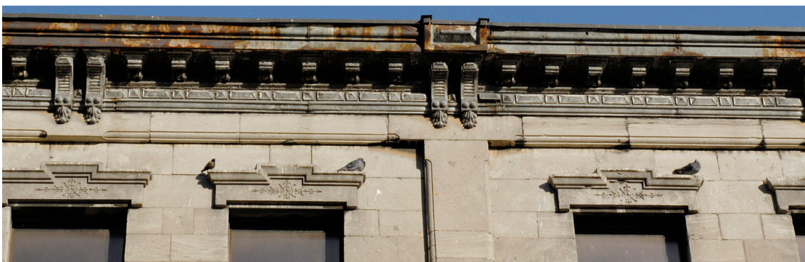
Détail du travail de la pierre de taille et de la corniche. 2010
