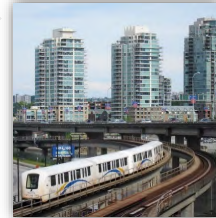
Photographie 8-2 : Site propre protégé, Skytrain, viaduc Dunsmuir entre la station Chinatown et le centre-ville de Vancouver, Canada
