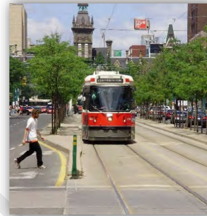
Photographie 8-1 : Site propre partagé, ligne sur Spadina Avenue, Tramway de Toronto, Canada
