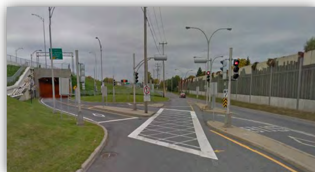
Photographie 4-1 : Photo : Accès au tunnel Chevrier via le boulevard Lapinière
