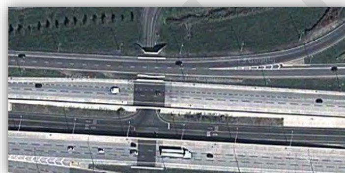
Photographie 4-2 : Accès au tunnel Panama, via le terminus Panama
