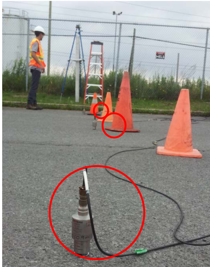
Figure 7-7 : Emplacement des capteurs à l'extérieur des studios Mel's
