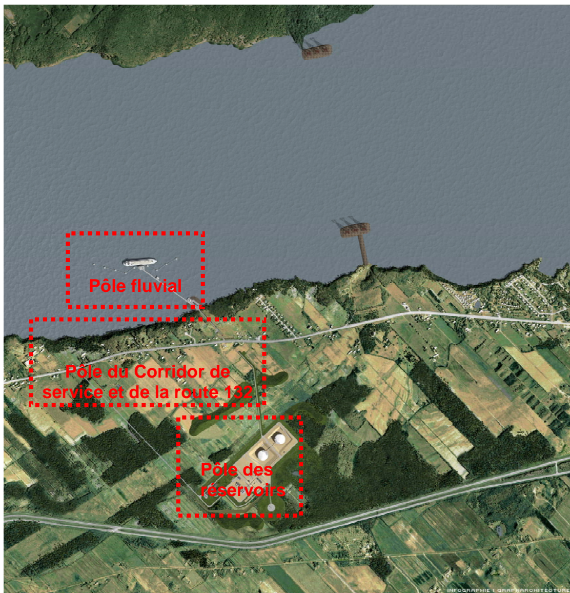
Figure 8 : Les infrastructures du terminal méthanier Rabaska
