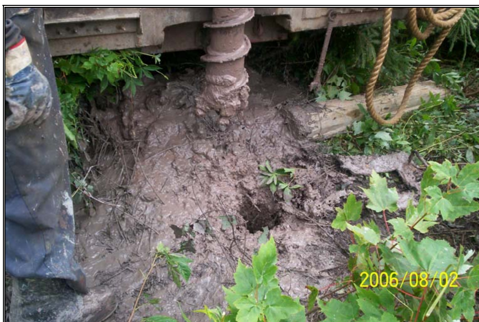
Photo N° 19 : Vue de la tarière à la fin de l'un des forages
