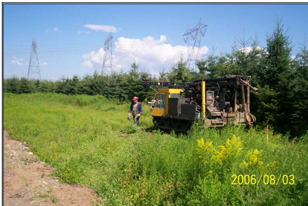
Photo N° 18 : Mise en place de la foreuse pour la réalisation de l'un des forages
