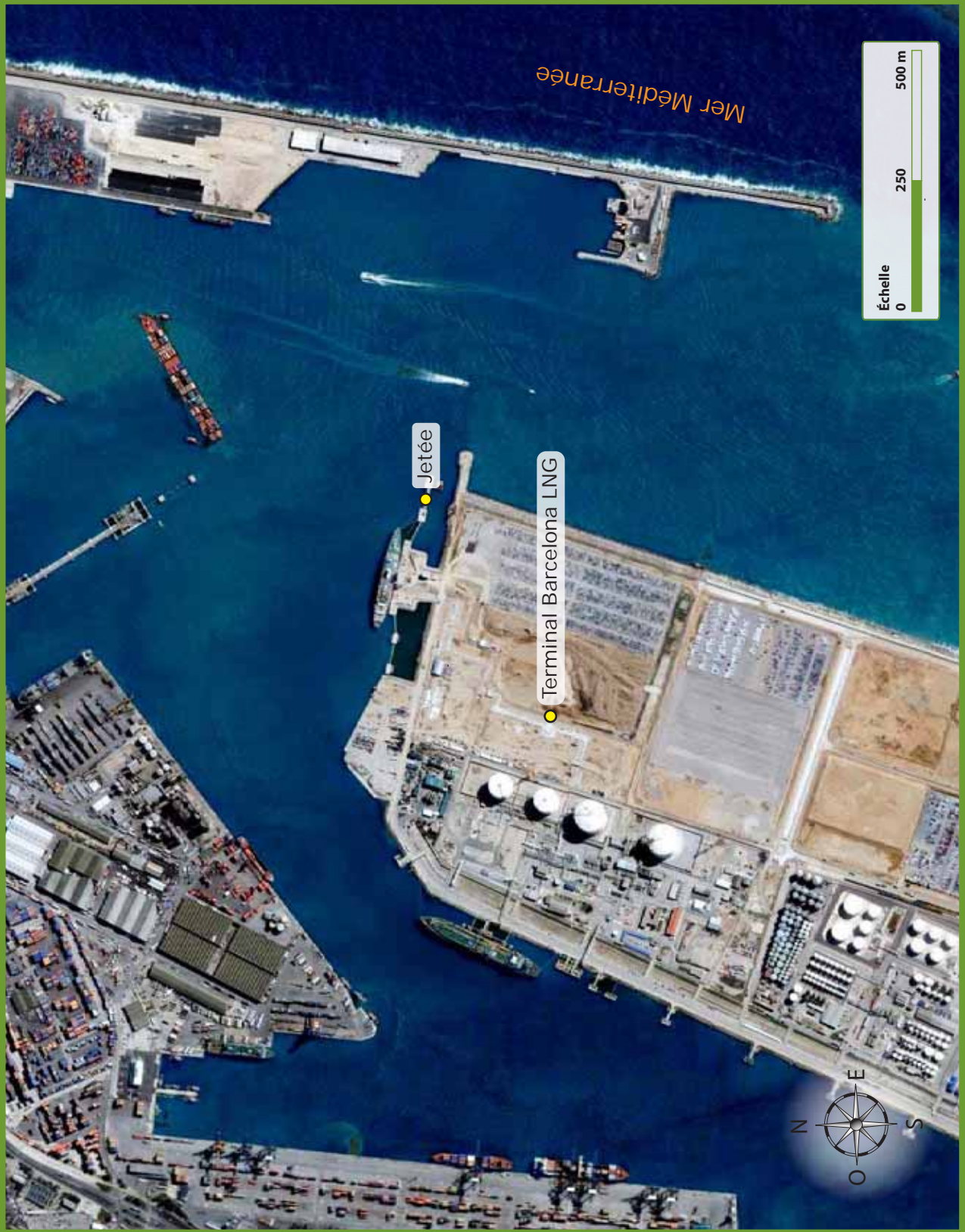
Espagne, Barcelona LNG Terminal (élévation de 2 km)
