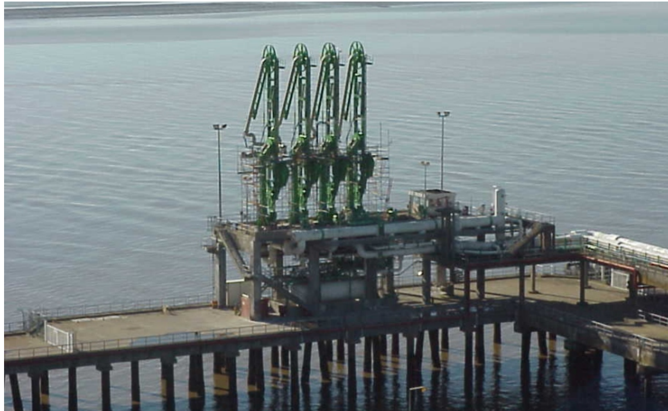
Bras de déchargement sur un des appontements du terminal méthanier de Montoir-de-Bretagne / Unloading arm at a jetty head of the Montoir-de-Bretagne LNG terminal
