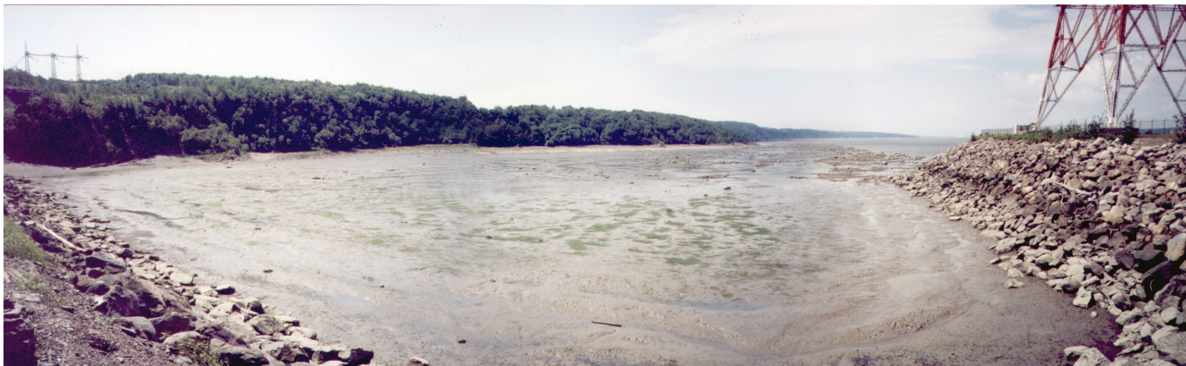
VUE À L'OUWEST DE LA JETÉE / WEST VIEW FROM THE JETTY
