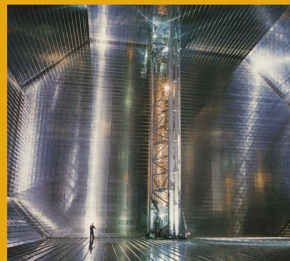
Intérieur d'une cuve de méthanier en acier.
