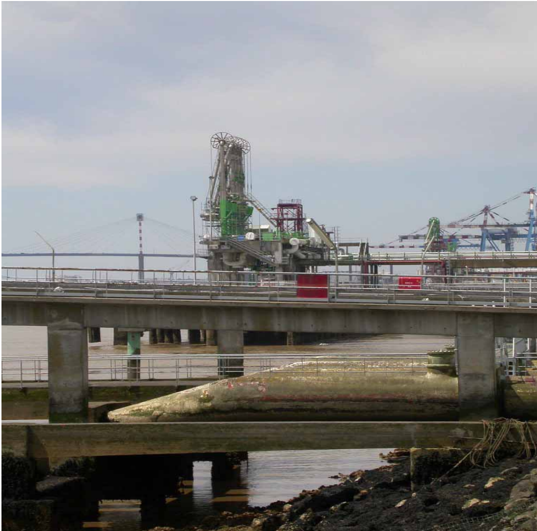
Le double système de bras de déchargement et de conduites au quai de Montoir-de-Bretagne.
